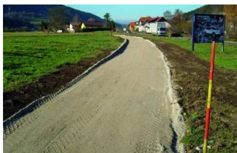
Slika 9: Nasutje tampona/peska. ( http://www.dravograd.si )
