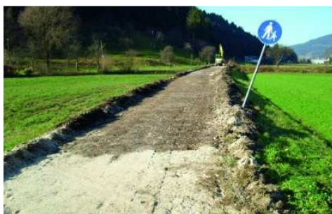
Slika 8: Odkop humusa. ( http://www.dravograd.si )
