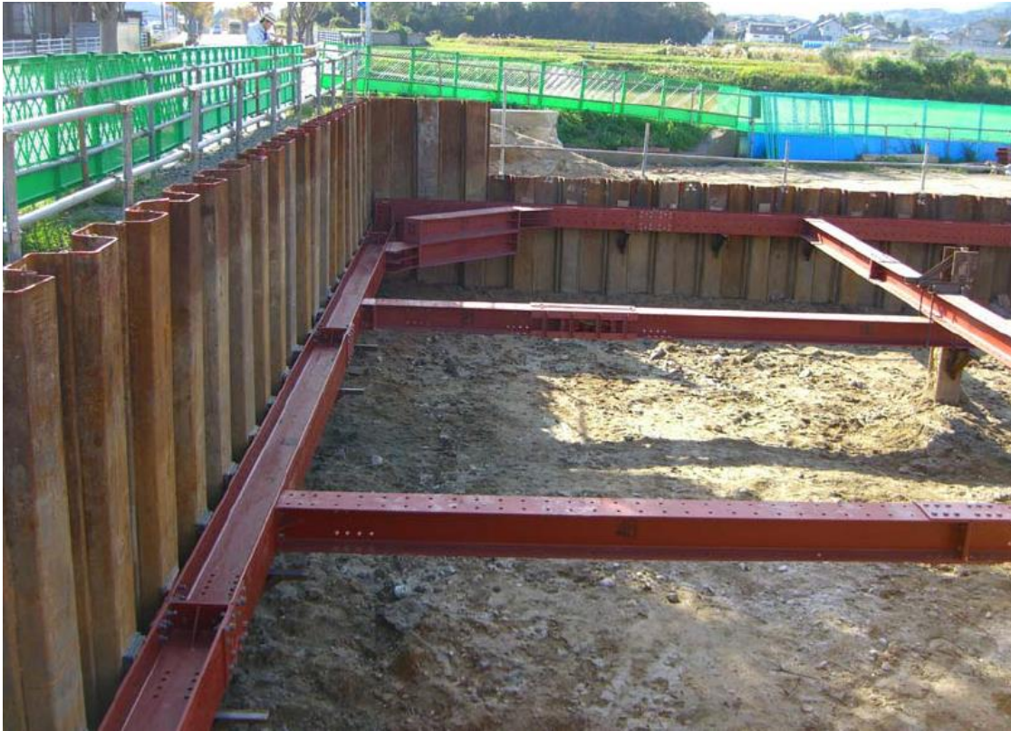
Slika 16: Razpiranje z jeklenimi nosilci. (Vir: Majes, 2013)
