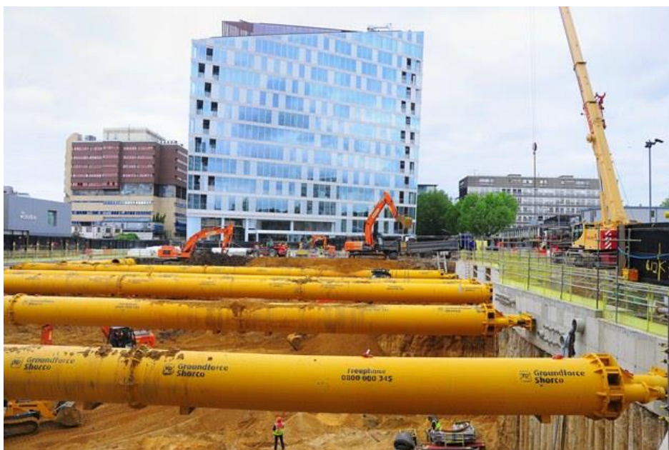
Slika 18: Razpiranje s hidravličnimi razporami.
