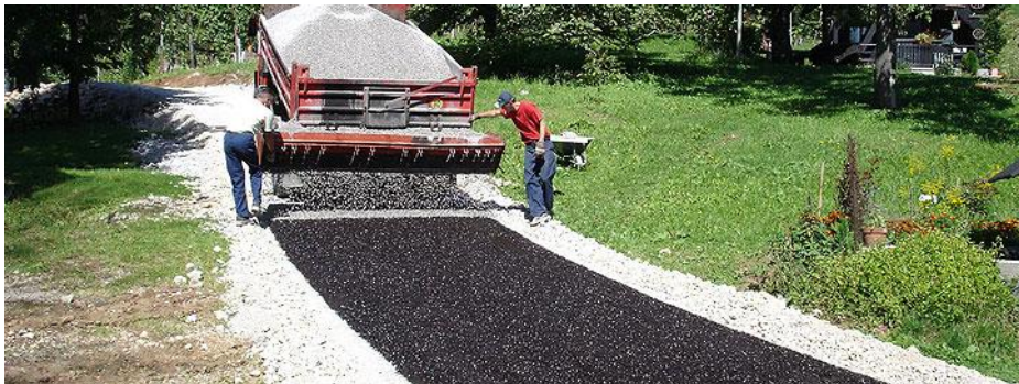
Slika 7: Izvedba s površinsko prevleko na tamponsko podlago. (Vir: http://www.vianova.si/storitve/povrsinske-prevleke-na-makadam )
