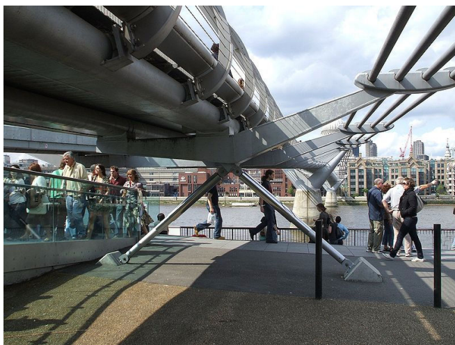
Slika 39: Viskozni dušilci na mostu Millennium Bridge (Farrance, 2010)
