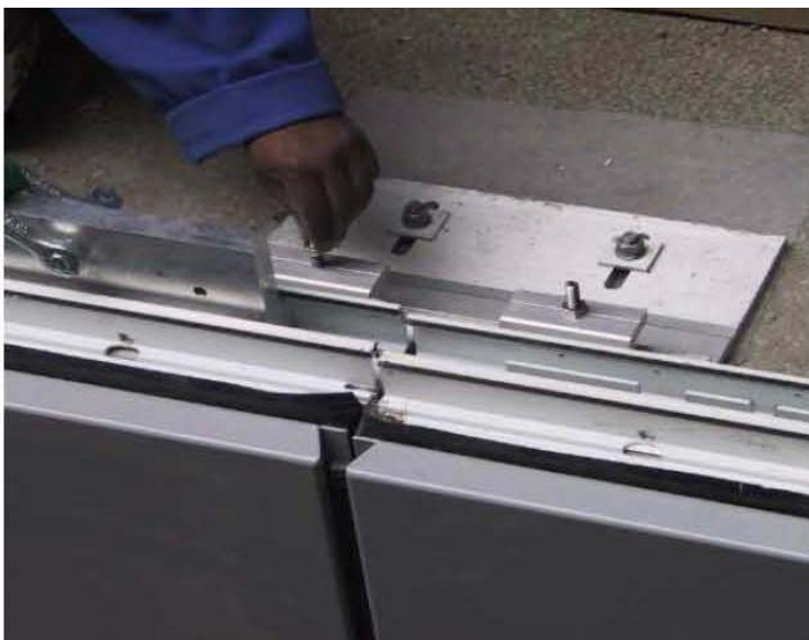
Slika 16: Pritrditev panela na ploščo
