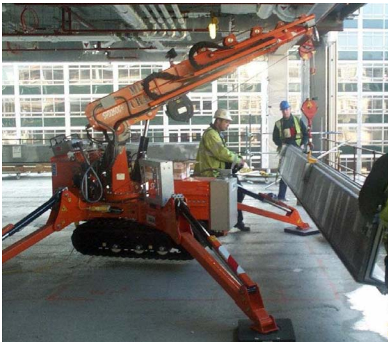
Slika 14: Stroj za montažo panelne fasade
