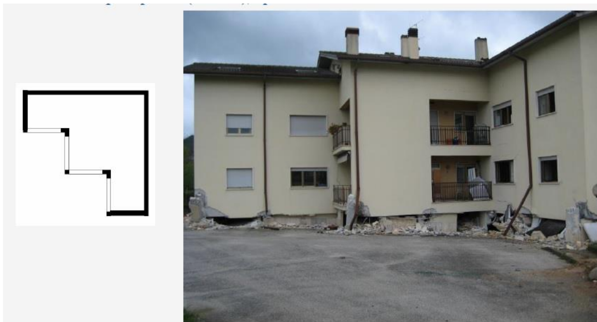
Slika 4: Primer nezveznosti po tlorisu (Dolšek, 2011)
