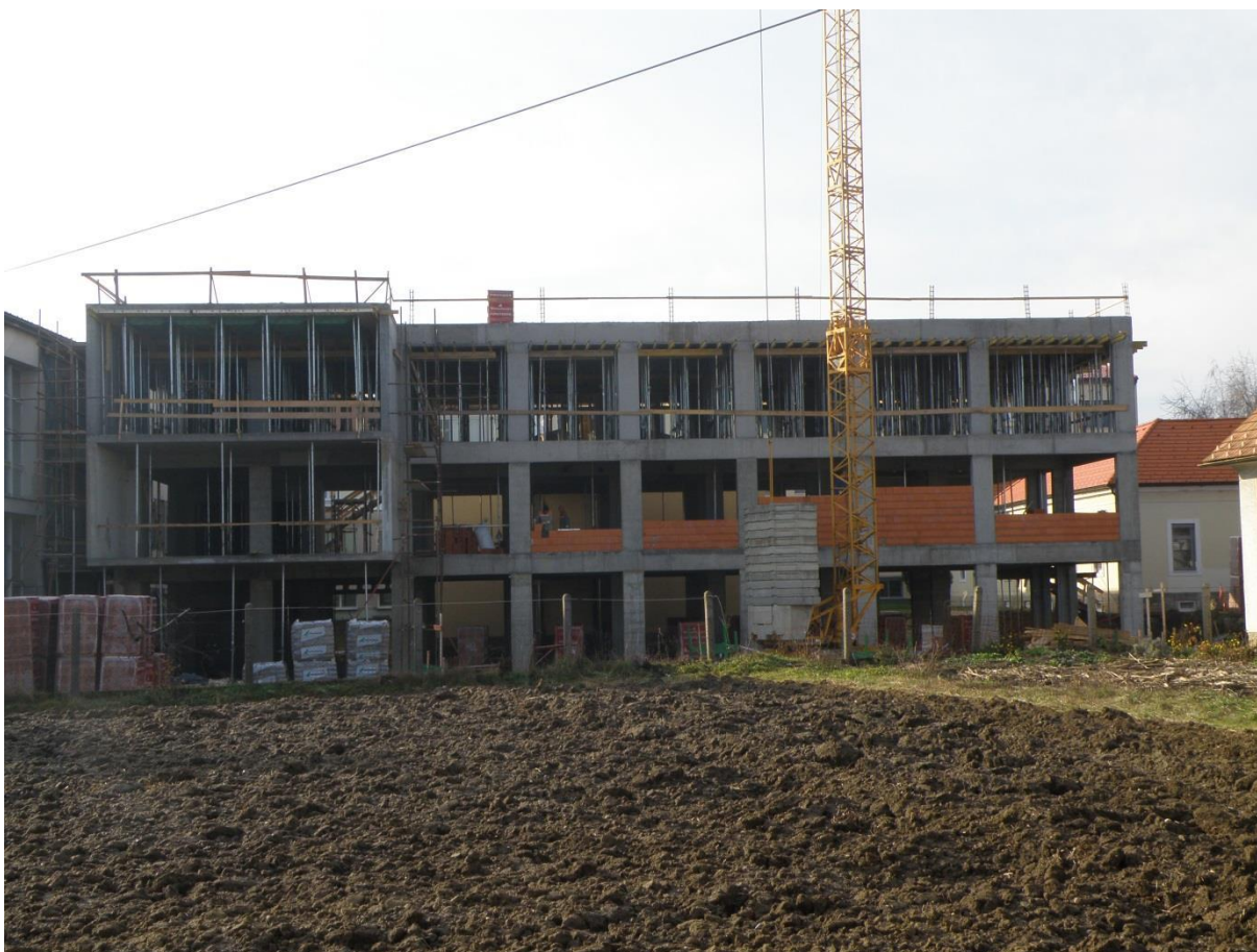
Slika 1: Primer armiranobetonske konstrukcije s polnili
