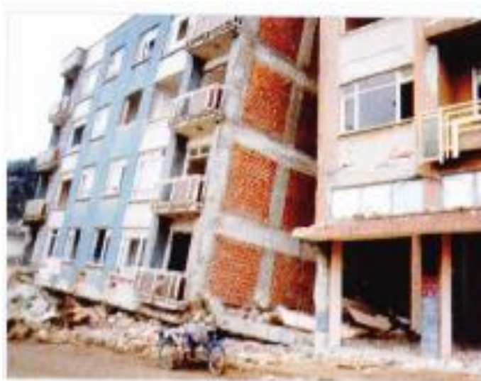
Slika 3: Primer nezveznosti po višini (Tomažević, 2009)
