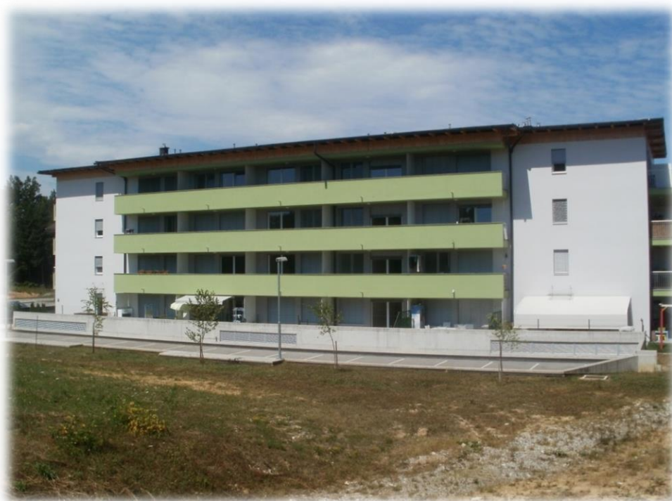
Slika 2: Pogled na jugovzhodno fasado obravnavane stavbe
