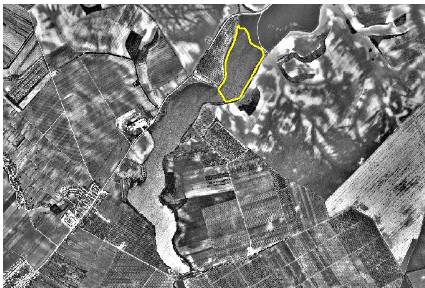
Slika 34: Ortofoto posnetek rezervoarja Bilovice (Sylabus akcion, 2012)
