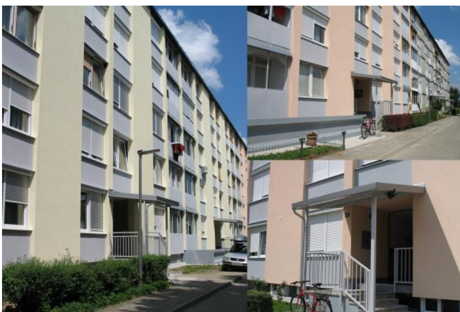
Slika 48: Kolaž fotografij: Energetske prenovljene stavbe v soseski Polje.
