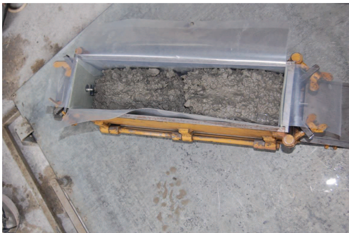
Slika 12: Vgrajevanje betona v kalup
