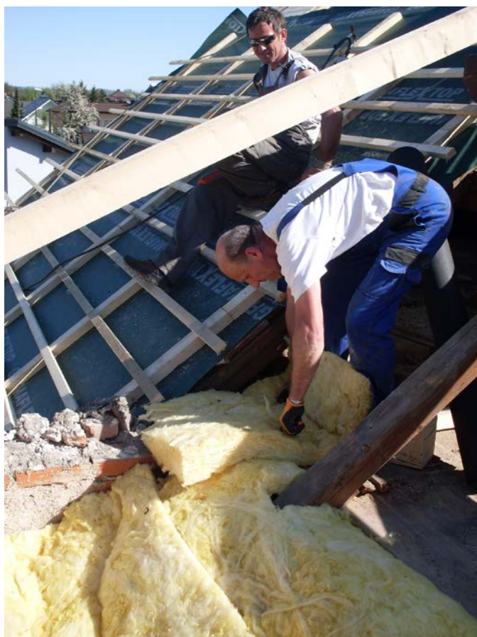
Slika 7 Prenova strehe, montaža steklene volne
