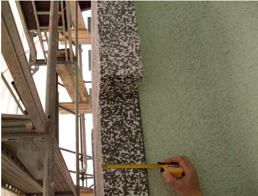
Slika 8 Prenova zunanjskega ovoja stavbe z izmerjeno debelino TI
