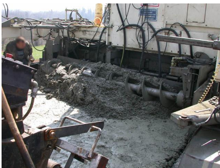
Slika 16: Vgrajevanje betonskega vozišča na pasu za počasna vozila [31].
