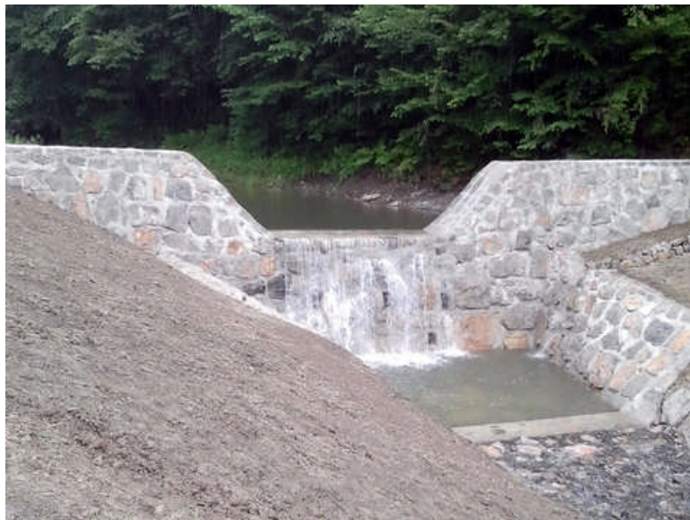
Slika 14: Ustavitevno – zaplavna pregrada (Hudourniška pregrada, 2013).
