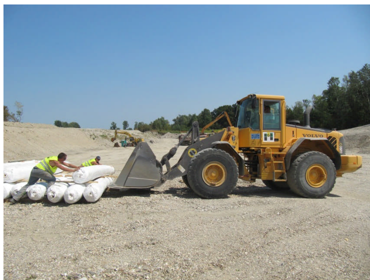
Slika 18: Nakladalnik pri pripravi nasipa (lasten vir, 2013).
