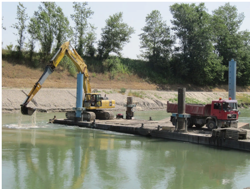
Slika 16: Bager pri delu na pontonu (lasten vir, 2013).
