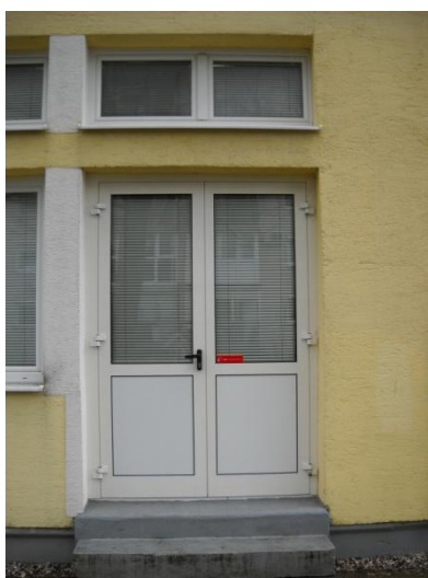
Slika 13: Požarna vrata (izhod E).
