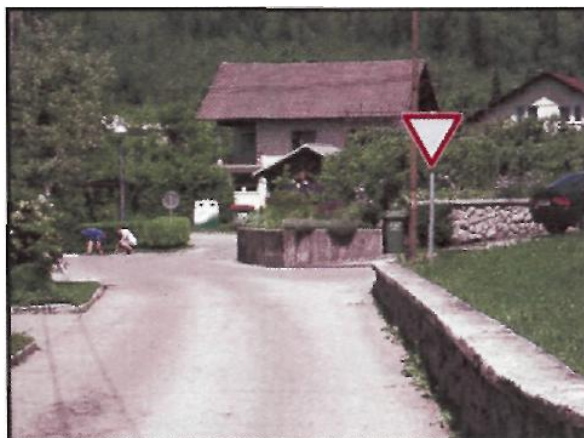
Slika 4: Nepregledno priključevanje pod ostrim kotom
