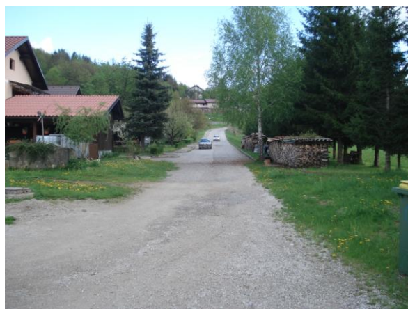
Slika 20: Mesto navezave – pogled v obratni smeri
