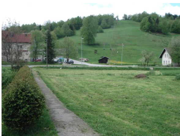
Slika 17: Pogled na obstoječi priključek ter mesto priključitve nove korigirane trase
