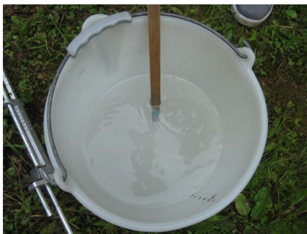
Slika 54: Priprava raztopine injiciranja
