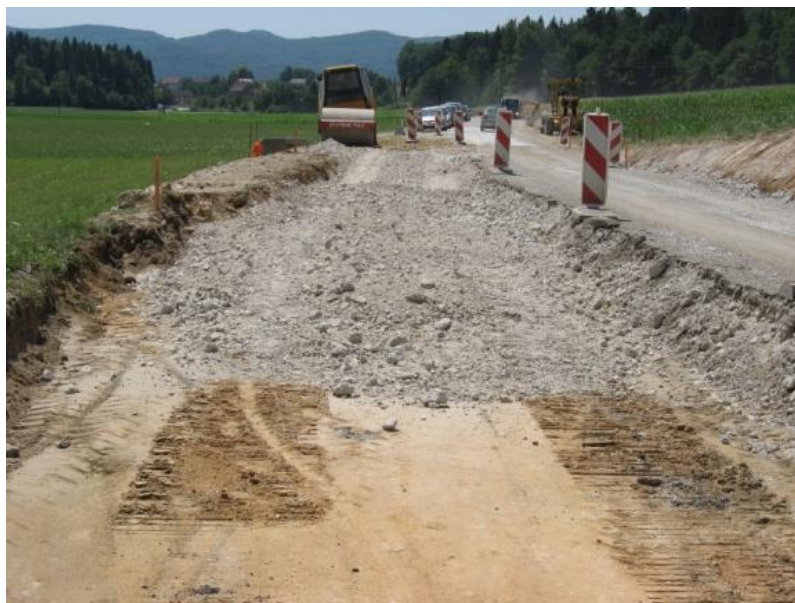
Slika 9: Recikliran betonski agregat kot nosilna plast v cestni konstrukciji (vir: foto arhiv ZAG)
