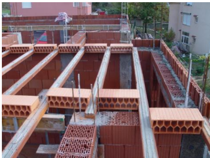
Slika 13: Prikaz zidanja po sistemu »Monta plošče« (Wienerberger I, 2013)
