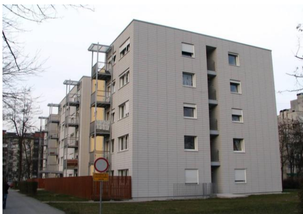
Slika 3: Pogled na južno in zahodno fasado (vir: [25] )
