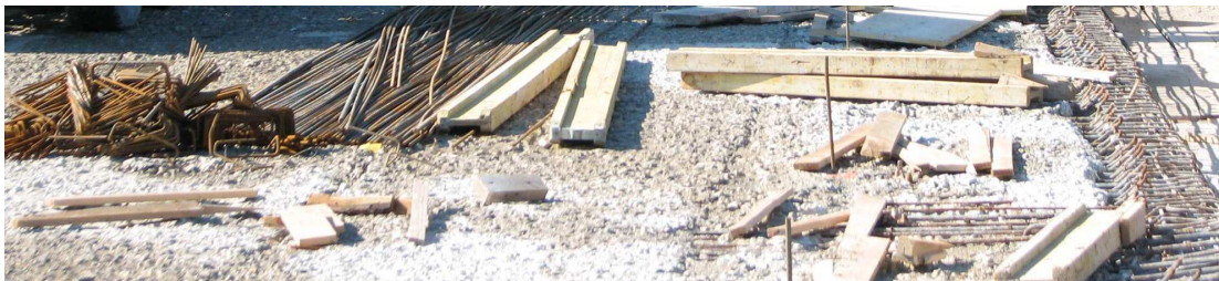
Slika 2.1: Površina betona po odstranitvi poškodovanega sloja.
