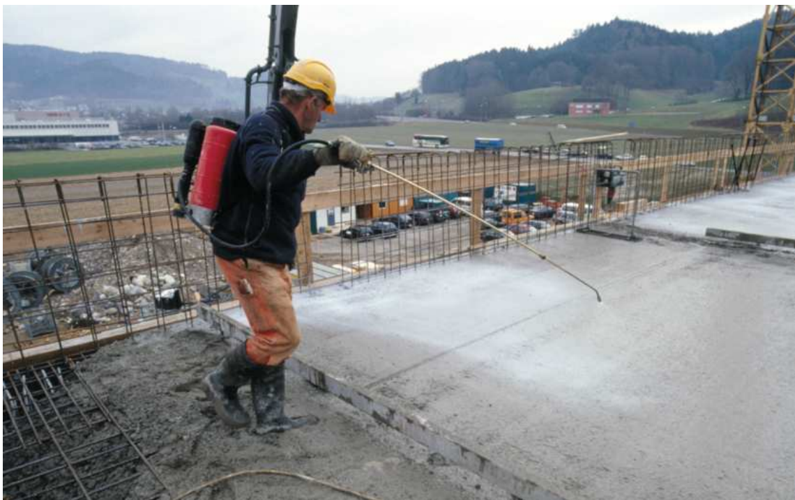
Slika 2.5: Nega s sredstvom za nego betona.
