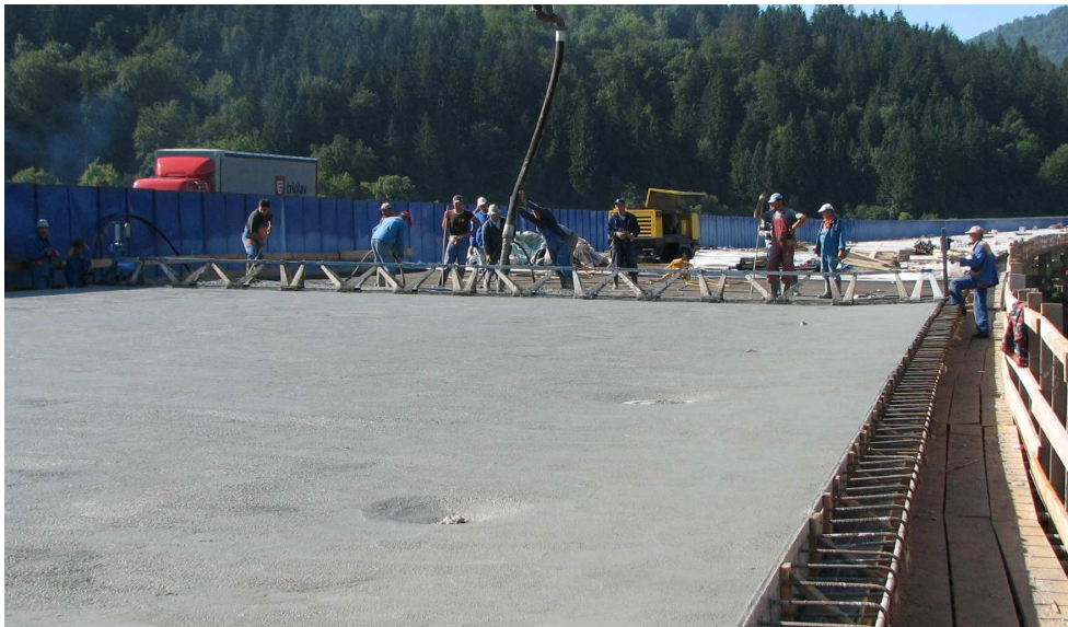
Slika 2.4: Primer betoniranja s samonosilno vibracijsko letvijo.
