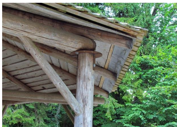
Slika 27: Stik stebra in nosilca ter povezava med njima
