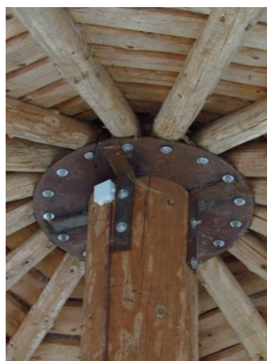
Slika 29: Slemenska povezava vseh špirovcev
