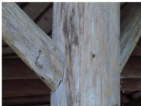
Slika 28: Stik stebra in diagonalne ojačitve
