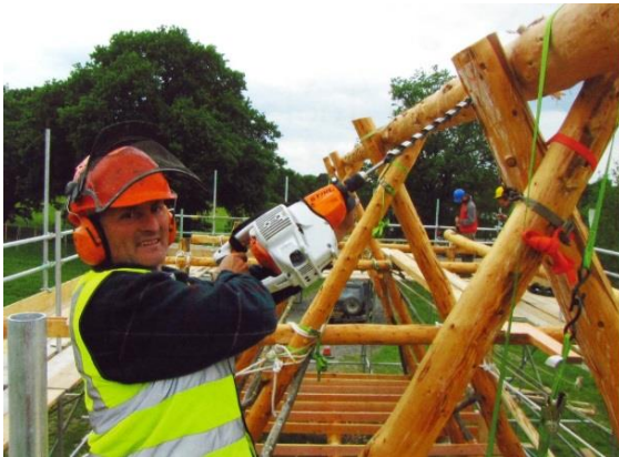
Slika 8: Ben Law med vrtnjem lukenj z motornim vrtalnikom (Law, 2010: str. 45)
