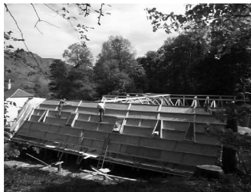
Slika 33: Med gradnjo (Chrip, Cairns, Gulland, 2003: 277 str.)
