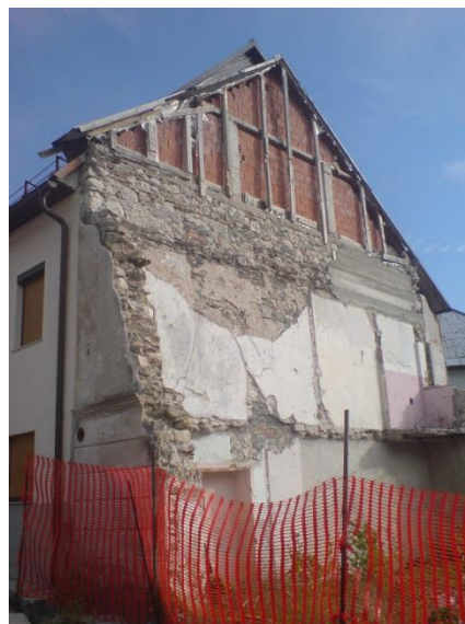
Slika 4: Razlika med poškodovanostjo starih in novih objektov (Earthquake Damage in Bovec, 2013)
