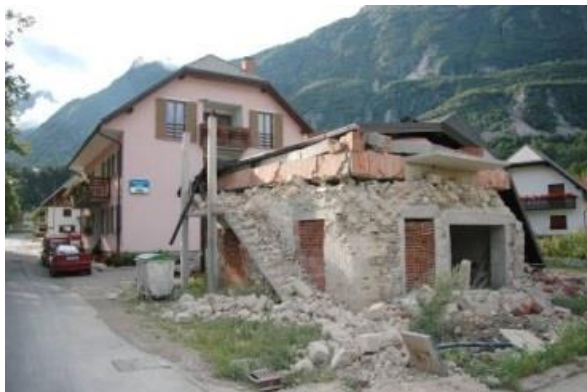
Slika 4: Razlika med poškodovanostjo starih in novih objektov (Earthquake Damage in Bovec, 2013)
