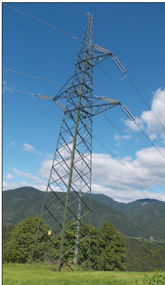
a) zatezni steber [Inštitut za metalne konstrukcije, 2013]
