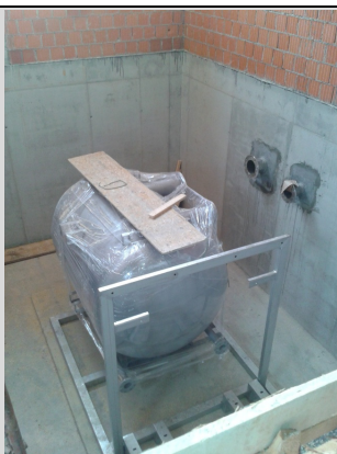
Slika 21: Podtlačna posoda v podtlačni postaji Ponikve
