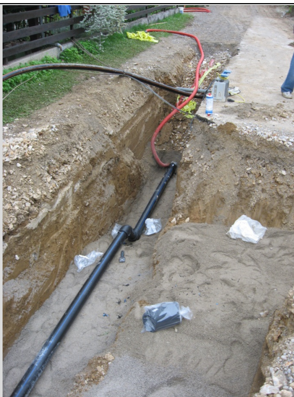
Slika 19: Višinski skok na podtlačnem vodu, zaščitna cev (rdeča - Stigmaflex) za monitoring
