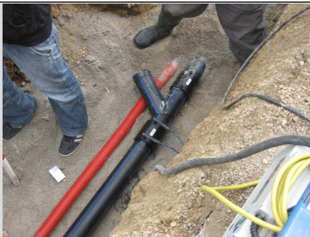
Slika 6: Odcep varjen z elektro varilno spojko
