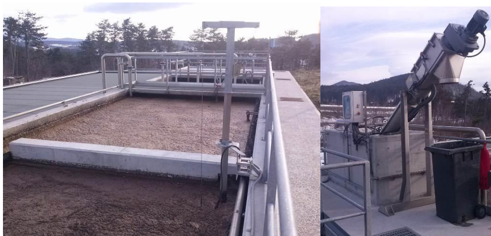
Slika 37: Prezračevalni bazeni in mehanske grablje (Foto: Matjaž Ozbič)
