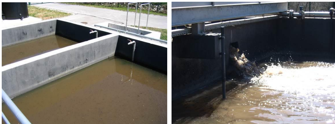
Slika 24: Levo usedalni bazen. Desno prečrpavanje vode s pomočjo zraka (Foto: Matjaž Ozbič)
