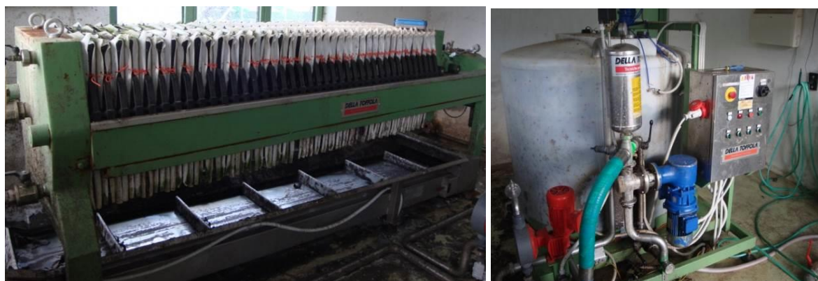
Slika 32: ČN Divača filterna stiskalnica in naprava za mešanje blata z polielektrolitom, z mešalno posodo velikosti 1m3 (Foto: Matjaž Ozbič)
