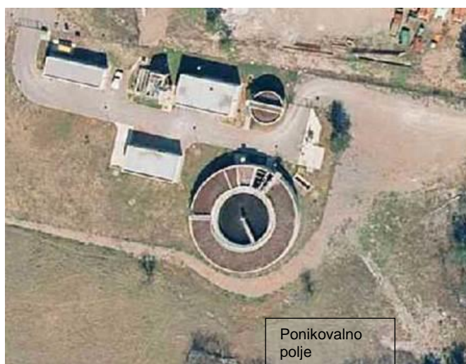
Slika 20: Posnetek čistilne naprave Sežana (PISO, 2012)
