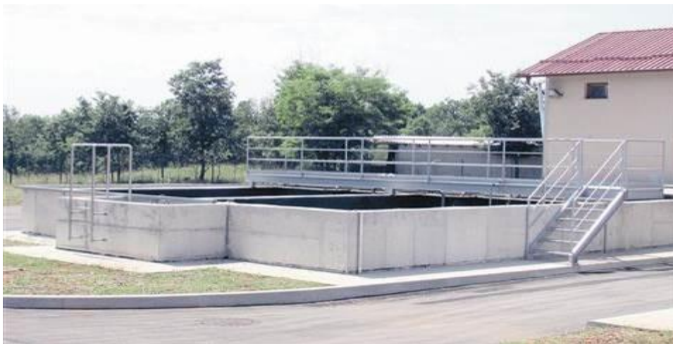
Slika 21: Čistilna naprava Komen (Foto: Matjaž Ozbič)
