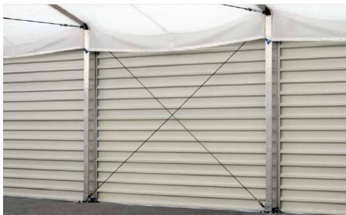
Slika 7: Primer izvedbe diagonal (vir: katalog proizvajalca Herchenbach)
