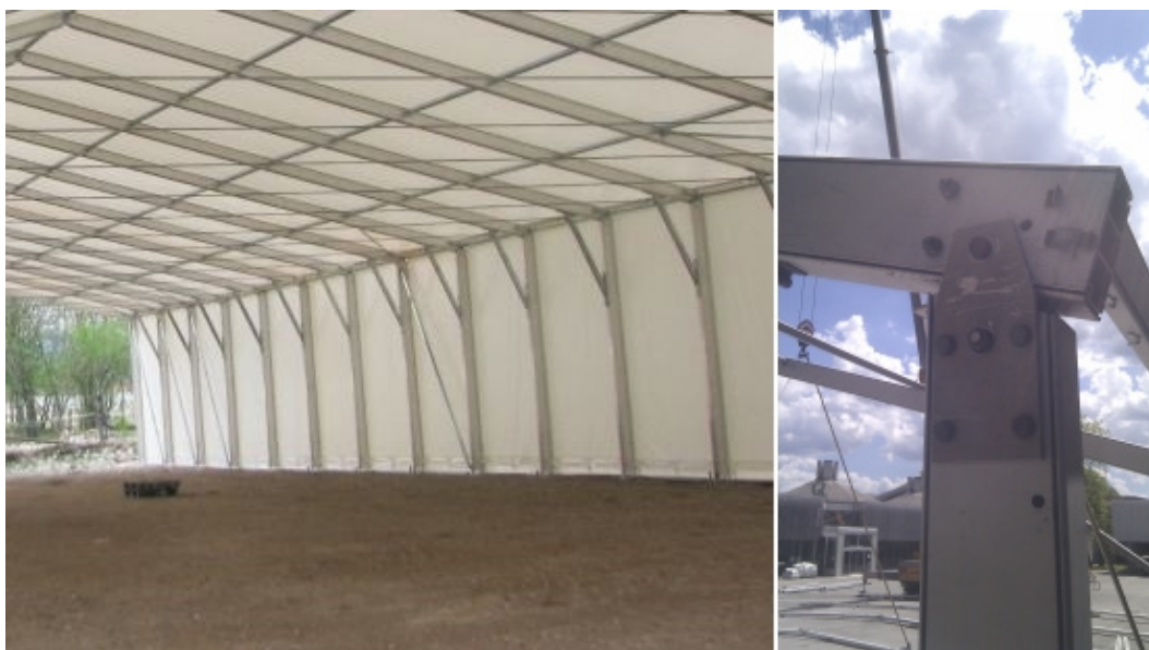
Slika 6: Dodatno ojačan spoji s tlačnimi razporami (vir: Biro Ogis)
