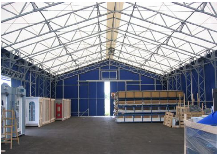
Slika 18: Notranjost objekta iz jeklene palične konstrukcije (vir: Konstrukcije Schwarzmann)
