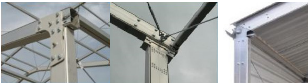
Slika 5: Različni primeri spajanja elementov okvirja (vir: katalogi proizvajalcev Röder HTS, Eschenbach, Herchenbach)
