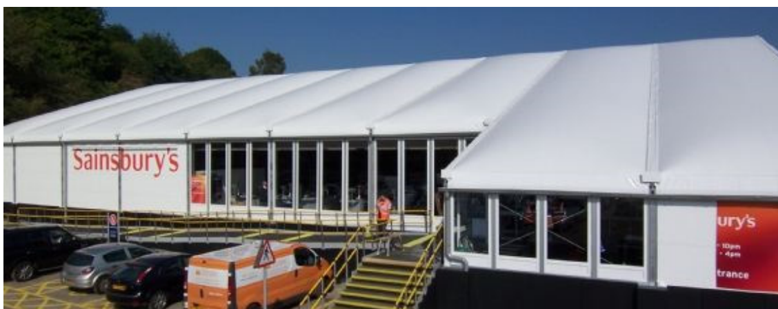
Slika 12: Izvedba s toplotno izolativno dvojno PVC ponjavo (vir: Röder HTS)
