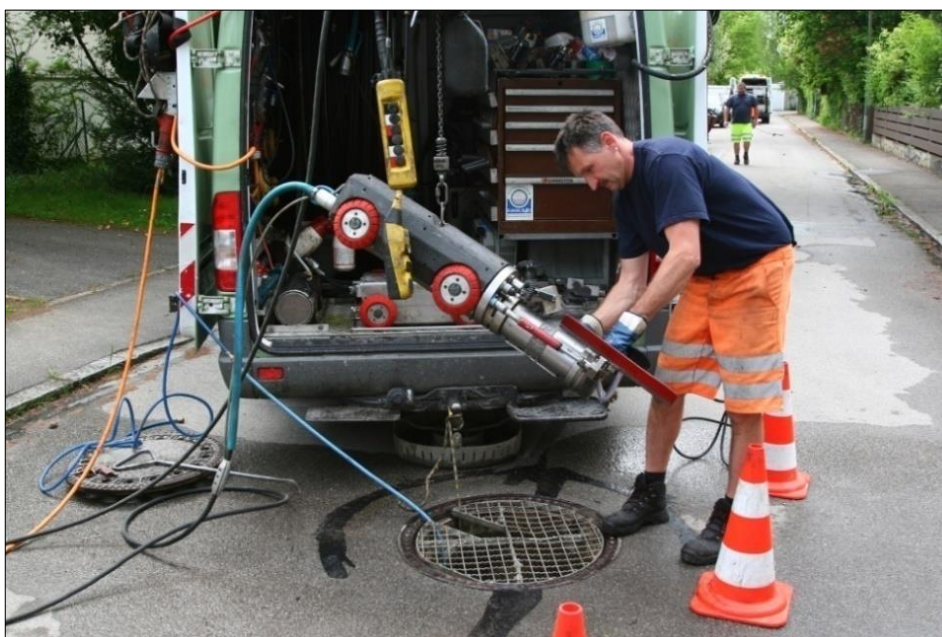
Slika 23: Primer vozila za sanacijo z naprednim robotom (Foto: Miha Žlindra, 9. 5. 2012)
