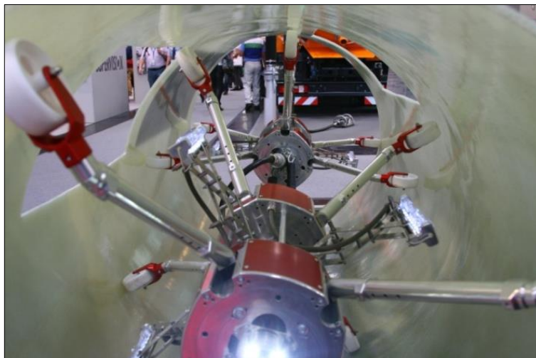
Slika 20: Primer naprave z UV svetlobnim virom (Foto: Miha Žlindra, 8. 5. 2012)
