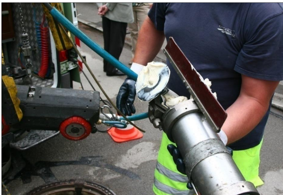
Slika 24: Robot za nanos epoksi lepila (Foto: Miha Žlindra, 9. 5. 2012)
