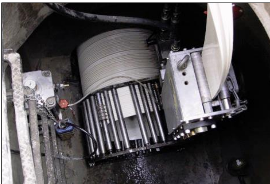
Slika 22: Tehnologija cev v cevi (Sanacije Geiger, 2012)
