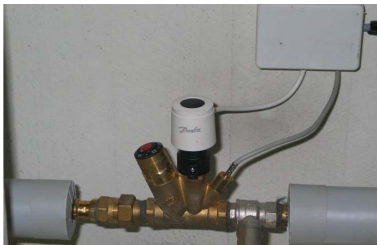
Slika 8: Prikaz vgrajenega modularnega termostatskega regulacijskega ventila (MTCV) z elektrotermičnim pogonom (model C)
