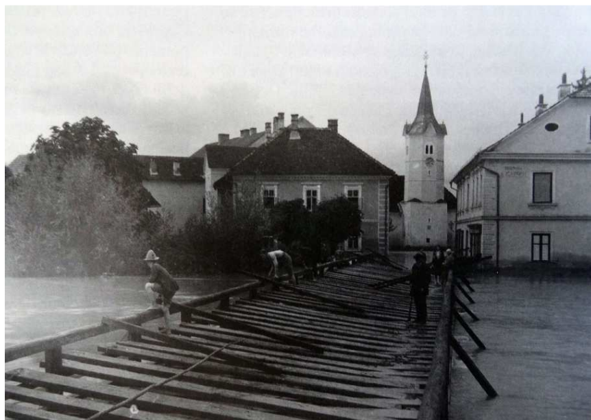
Slika 11: Ob poplavah so mostove zavarovali tako, da so dvignili podnice. Poplava pred letom 1948. (Orožen Adamič, 2003)
