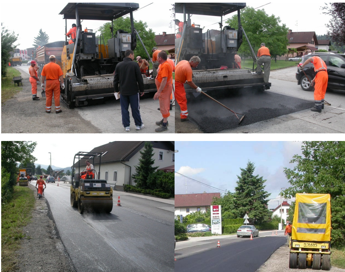
Slika 23: Vgrajevanje z gumo modificirane zmesi na Litijski (Pavšič, idr., 2010)
