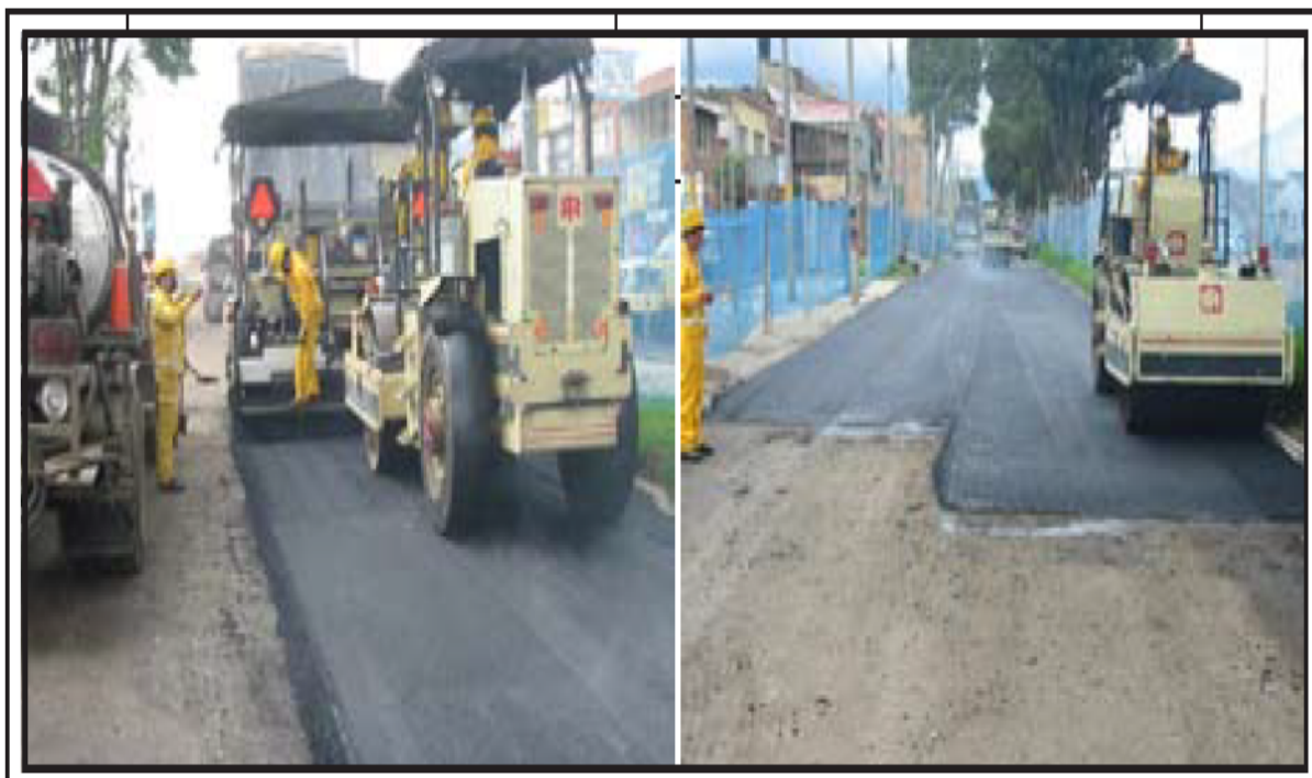
SLIKA 46: Vgradnja poskusnih asfaltnih plasti (Arguelles, idr., 2009)
