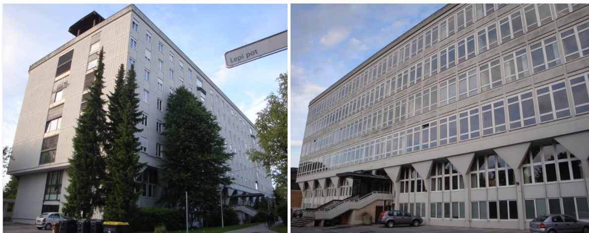
Slika 2: Fasada stavbe FGG (levo jugozahodna, desno severna fasada)
