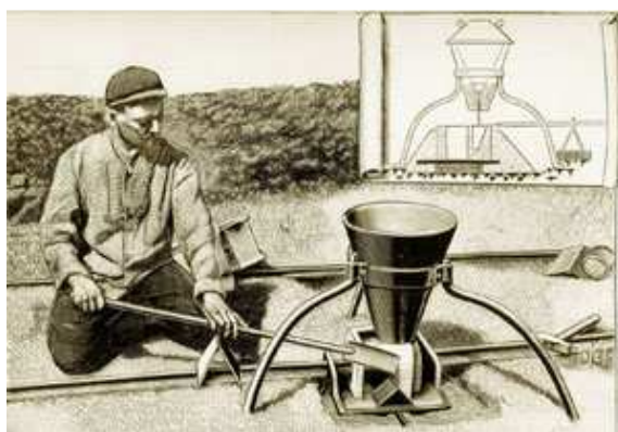
Slika 58: AT-varjenje v začetku 20. stoletja
