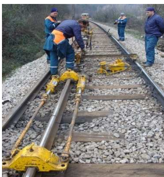
Slika 81: Hidravlični tenzor in pritrjevanje tirnice v območju tenzorja
