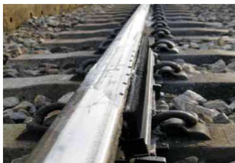
Slika 52: CL-E1 dozirno polje na progi Celje-Maribor z vidnimi dozirnimi vrtnami
