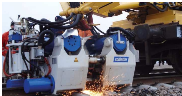
Slika 57: Naprava za mobilno elektroporovno varjenje
