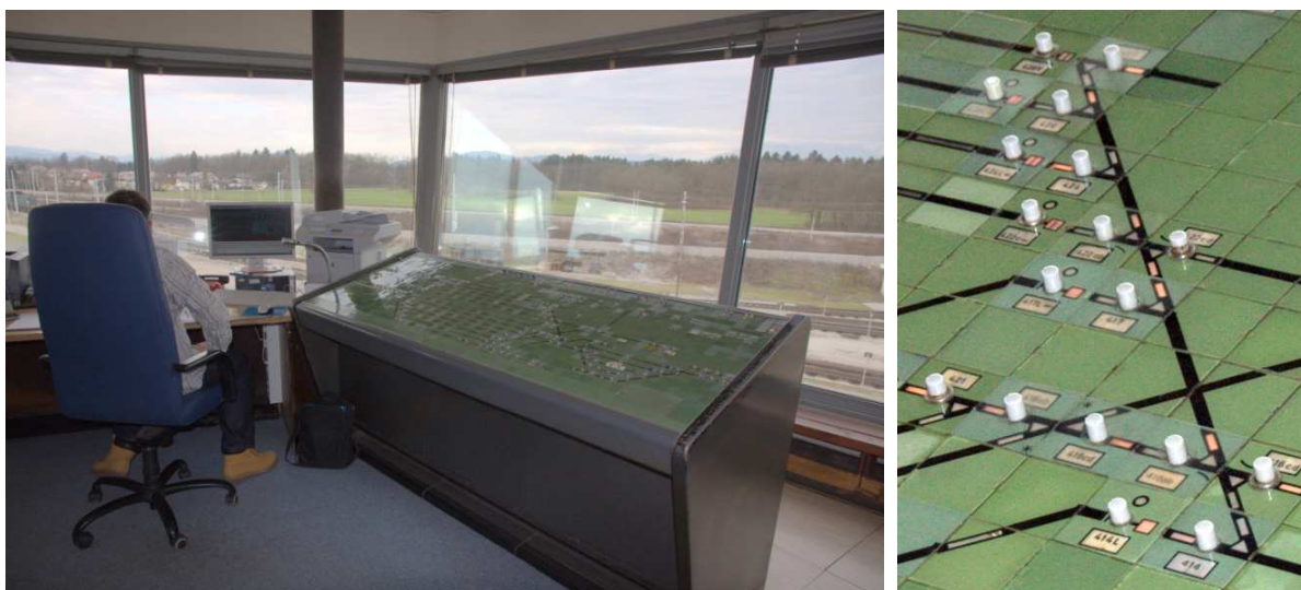
Slika 22: Kretniški komandni pult s podrobnim prikazom tipk (Vir: fotografiranje na ranžirni postaji Zalog dne: 12.1.2013)
