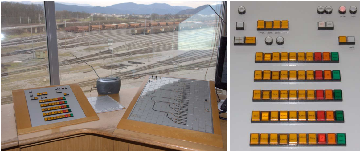
Slika 23: Komandni pult za zavorni sistem na drči s podrobnim prikazom tipk (Vir: fotografiranje na ranžirni postaji Zalog dne: 12.1.2013)
