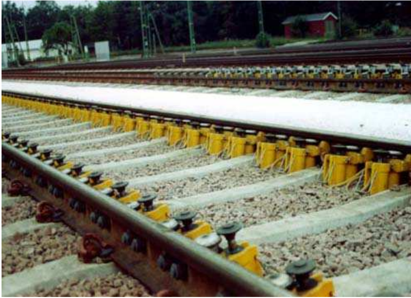
Slika 10: Sekundarne točkovne zavore (Vir: http://www.vlaki.info/forum/viewtopic.php?t=2577 (17.10.2012))
