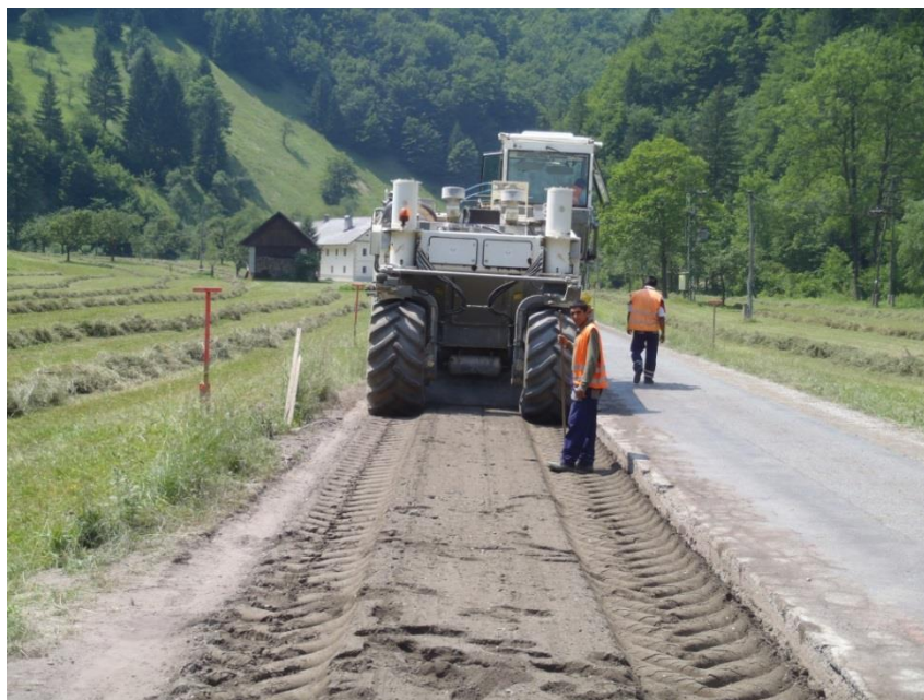
Slika 33: Tla po stabilizaciji (Bebar, 2013)
