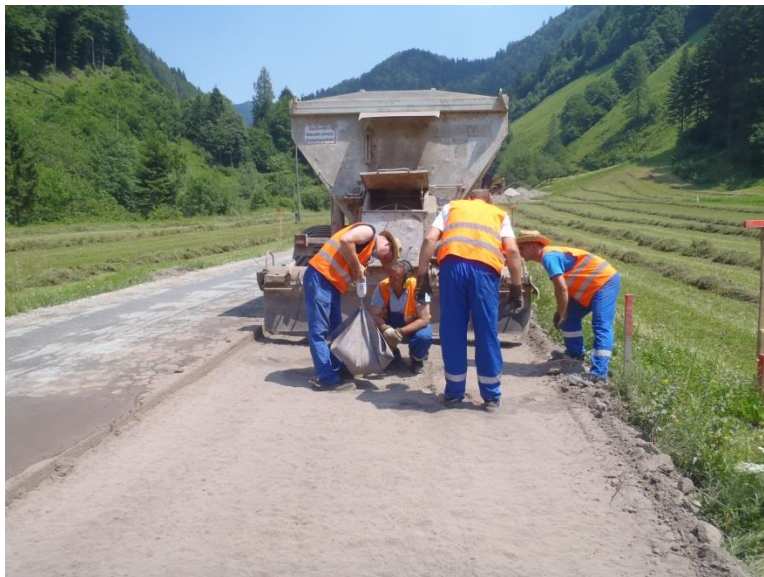
Slika 31: Kontrola količine posipa (Bebar, 2013)
