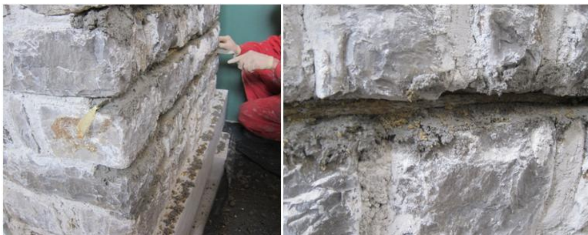
Slika 74: Vrvice, nameščene v fugah
