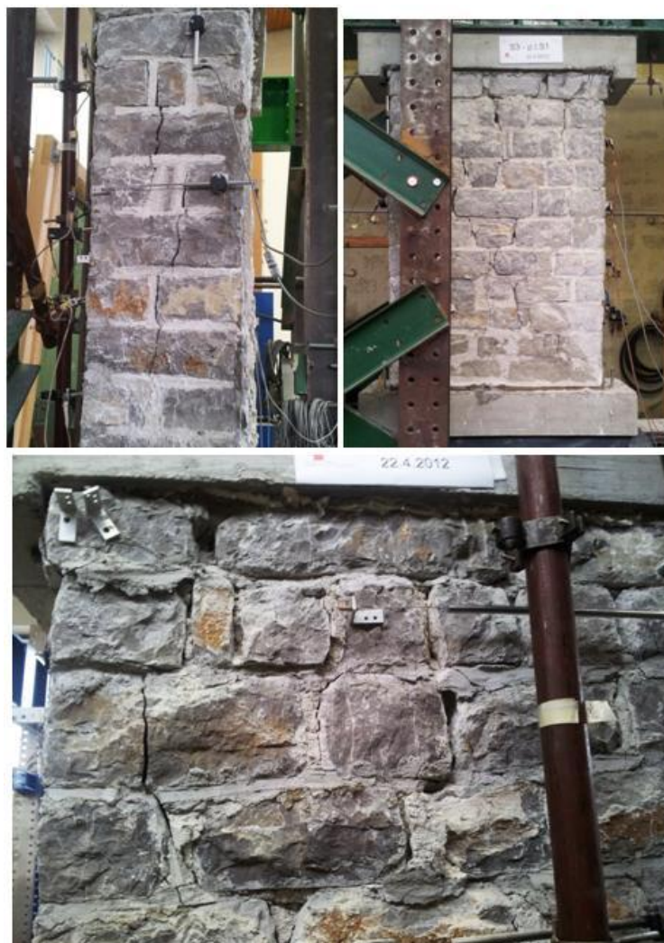
Slika 115: Poškodovanost injektiranega in dodatno utrjenega zidu
