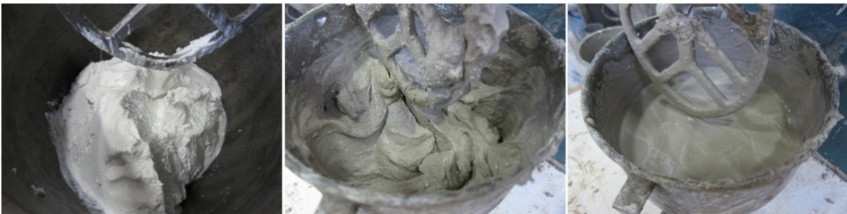
Slika 93: Pripravljanje injekcijske mešanice C
