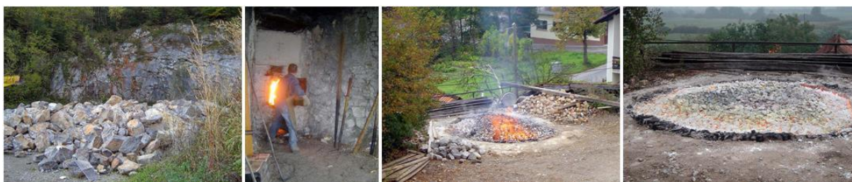
Slika 17: Star način pridobivanja apna ( http://www.beljenje.com/index.php/postopek )
