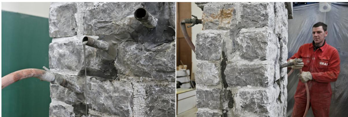
Slika 14: Injektiranje zidu in iztekanje injekcijske mešanice iz druge cevke
