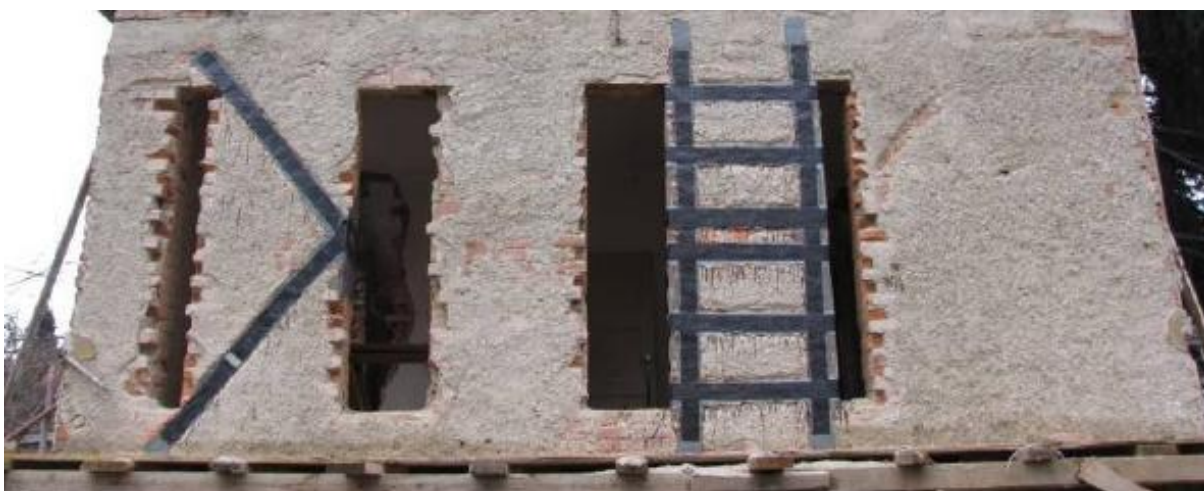
Slika 60: Diagonalna in kombinirana razporeditev karbonskih trakov [44]
