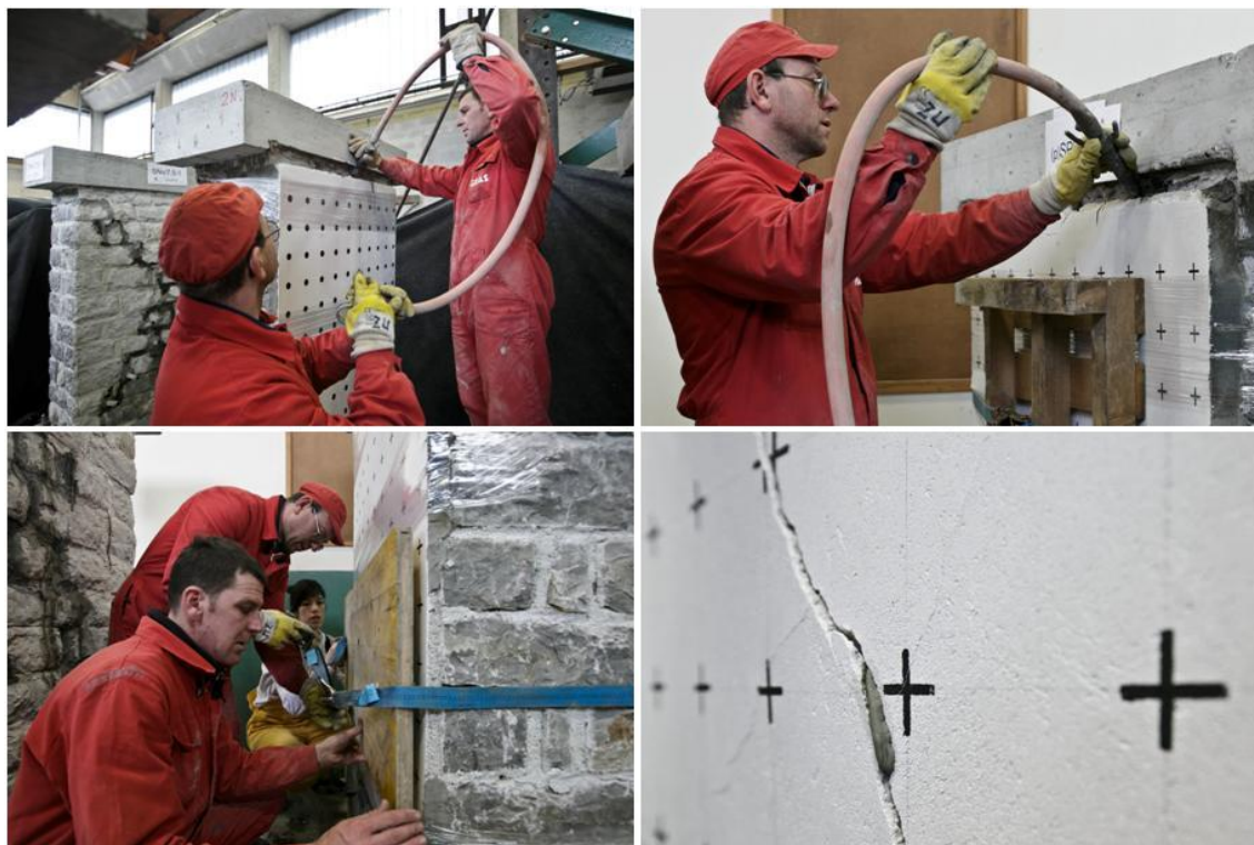
Slika 103: Injektiranje zidov za ometom
