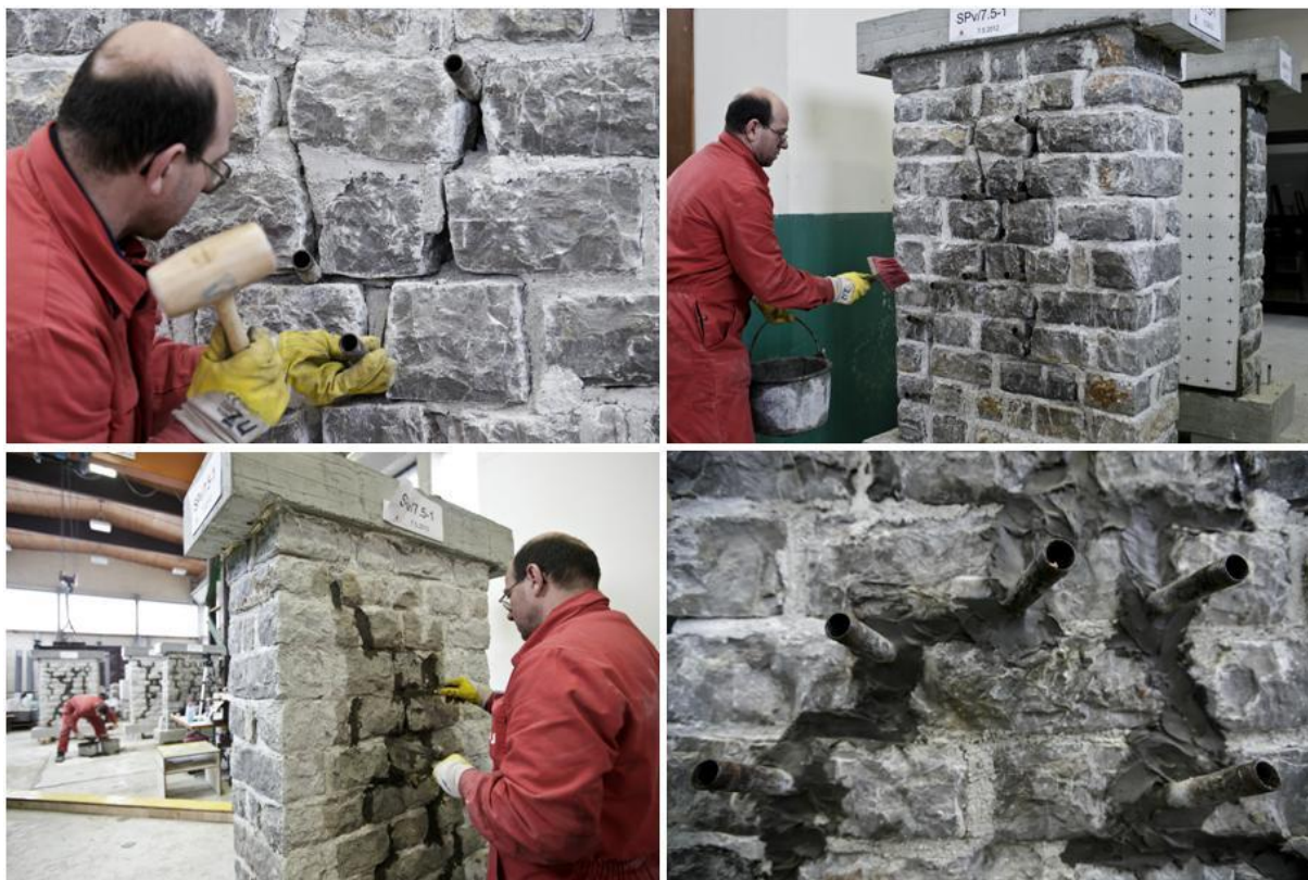
Slika 101: Priprava zidov za injektiranje
