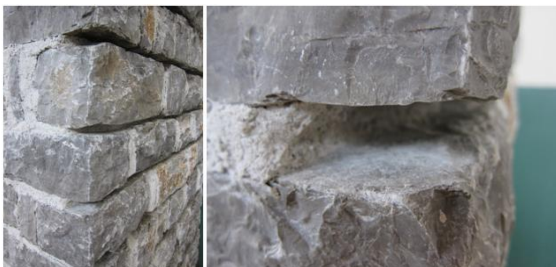
Slika 72: Izpraznjene fuge
