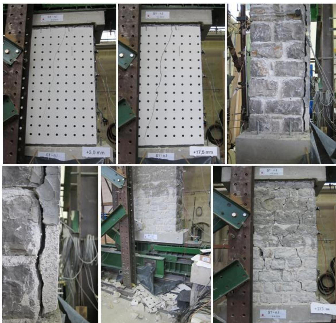
Slika 110: Poškodovanost injektiranega zidu
