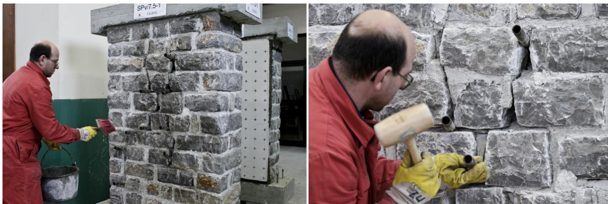
Slika 13: Vlaženje zidu in umeščanje cevk v zidove
