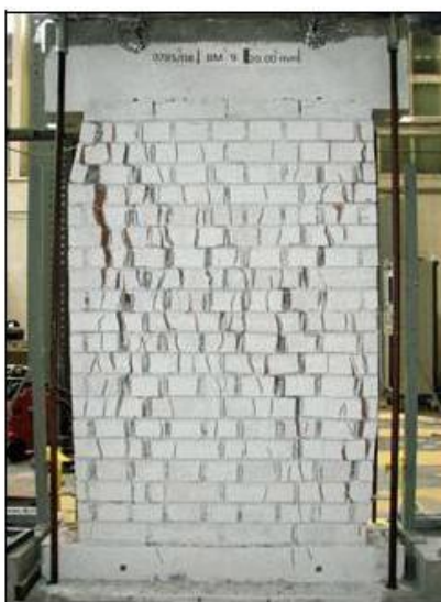
Slika 67: Porušitev neutrjenega zidu [50]
