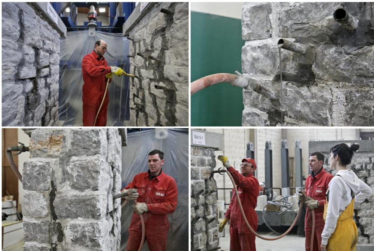
Slika 102: Injektiranje zidov
