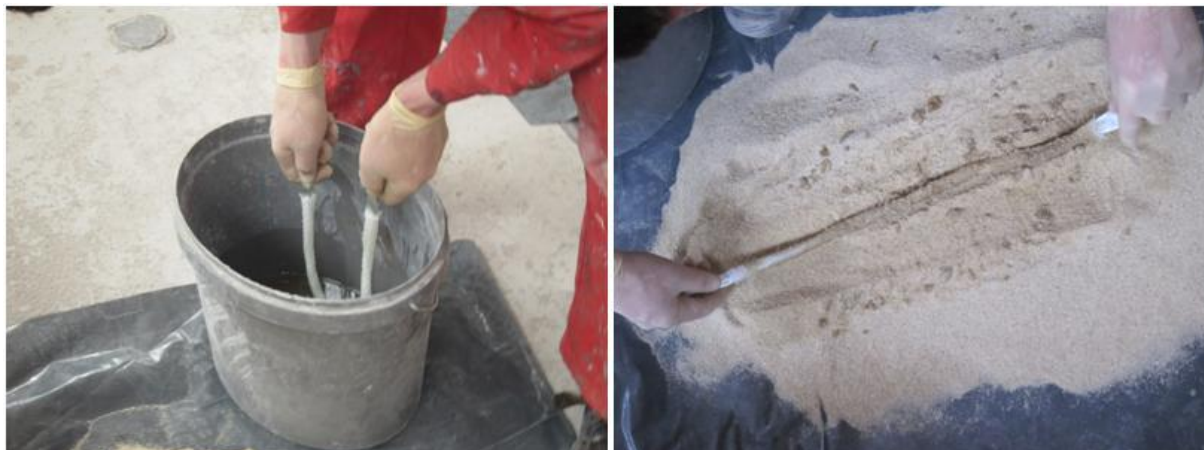
Slika 73: Namakanje vrvic v epoksi in valjanje vrvic v kremenčevem pesku
