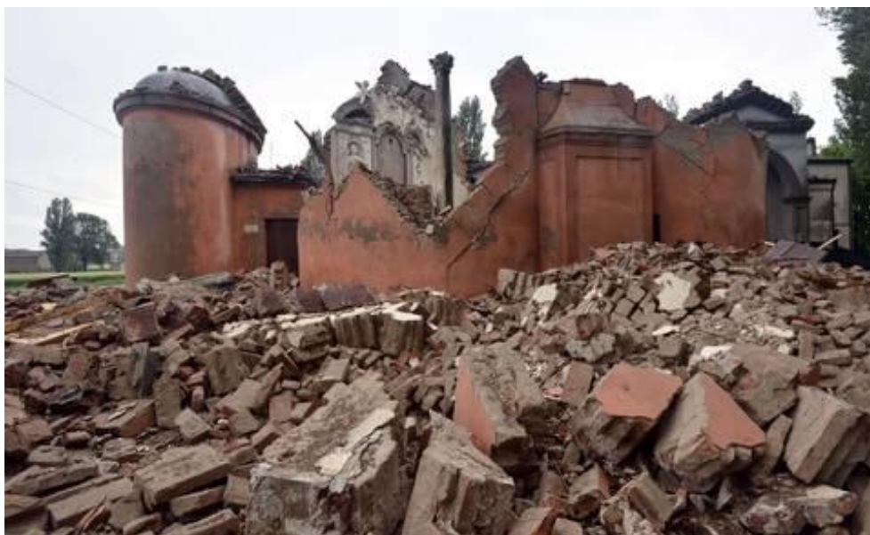
Slika 3: Porušena zidana stavba
