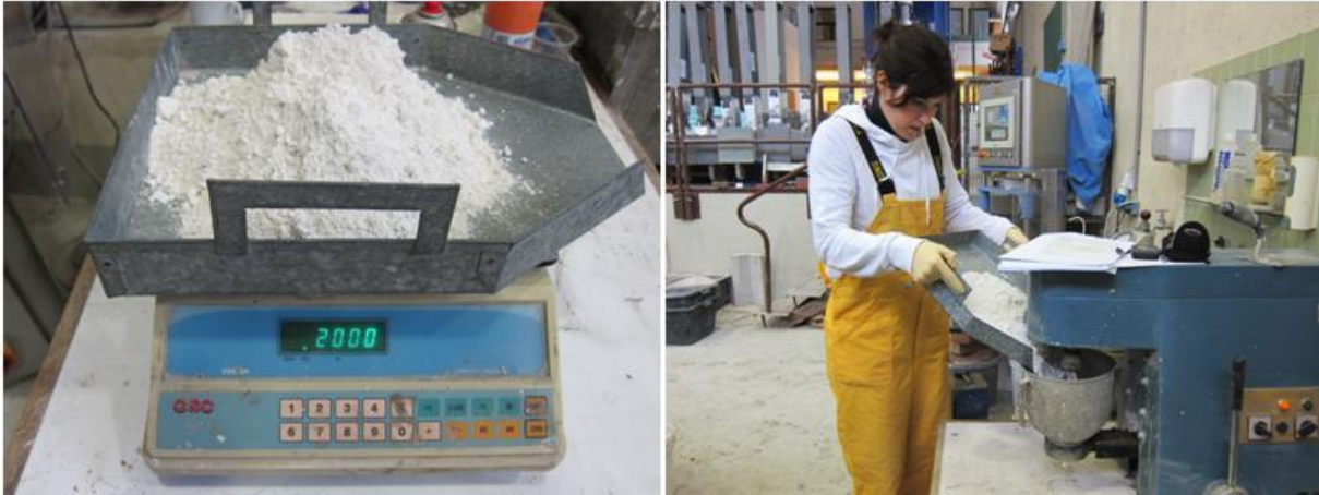
Slika 92: Pripravljanje injekcijske mešanice B
