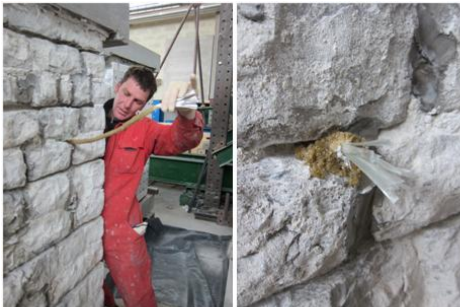
Slika 75: Povezovanje vseh treh slojev zidu z vrvico
