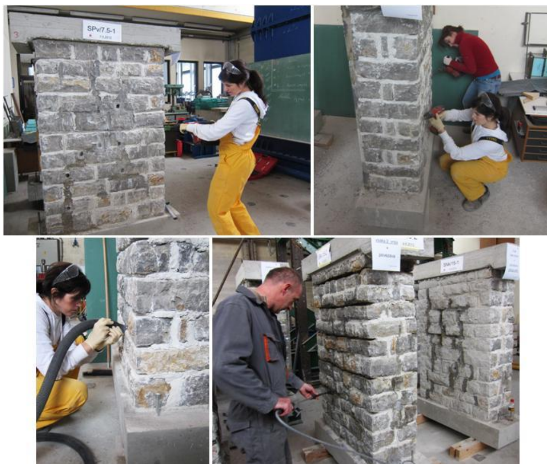
Slika 104: Izpraznitev in čiščenje spojnic
