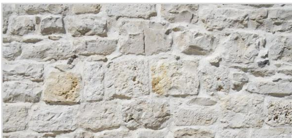
Slika 16: Zid z apneno malto
