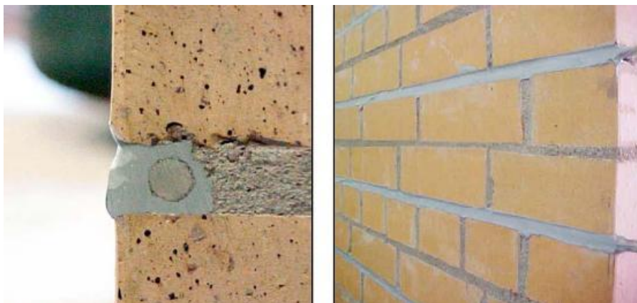
Slika 11: Primer NSM utrjevanja [19]
