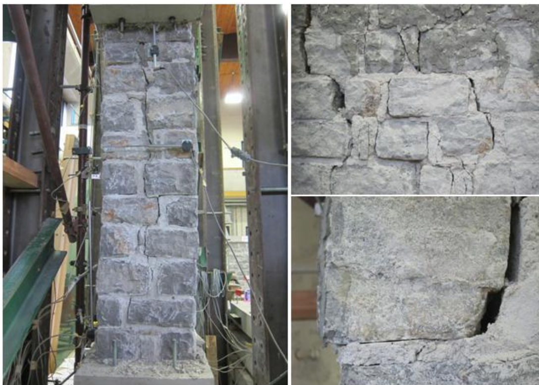
Slika 81: Poškodbe Zidu 1: izven ravninsko odpiranje zidu, izpraznjene spojnice, razpokani kamni
