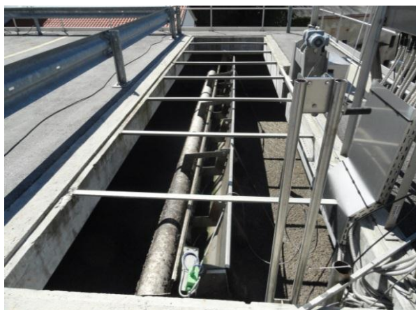
Slika 22: Dvignjen dekanter med fazo polnjenja in prezračevanja SBR
