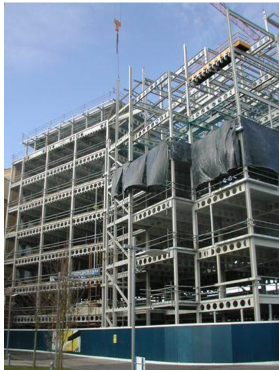
Slika 2: Gradnja jeklene nosilne konstrukcije večnamenske stavbe St James' Gate, Newcastle upon Tyne 4
