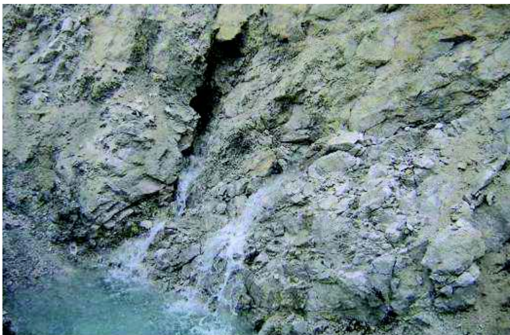
Slika 20: Prikaz dotoka vode v gradbeno jamo iz preloma kamnine
