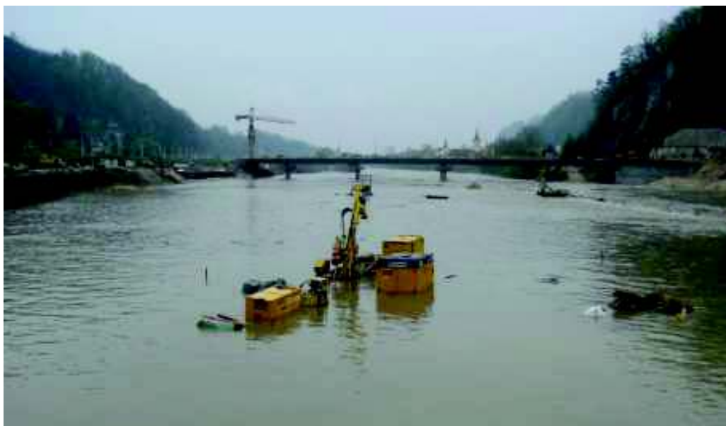
Slika 24: Poplavitve prve gradbene jame, na levem bregu (dolvodno)
