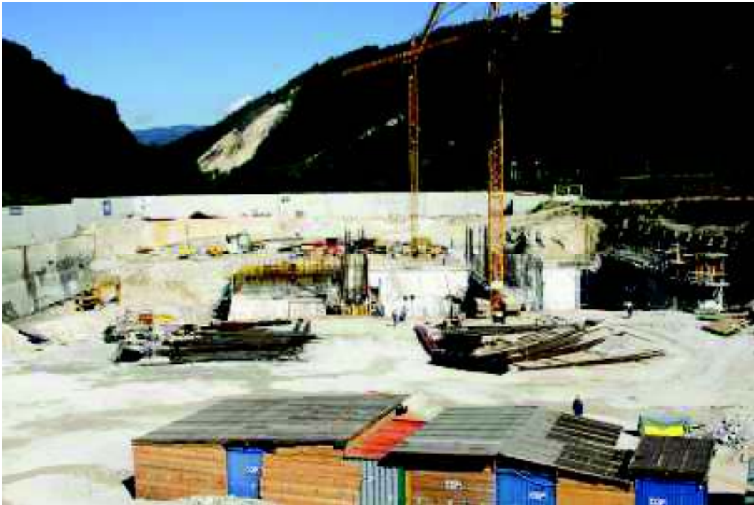
Slika 10: Gradnja natočnega dela prelivnih polj
