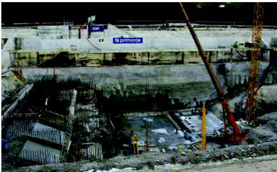
Slika 17: Gradnja spodnjega monolitnega dela- pretočnega trakta
