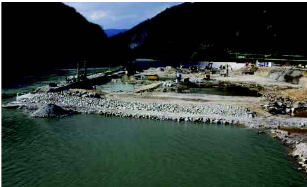
Slika 6: Izvedba prve gradbene jame, formirane na levem bregu Save
