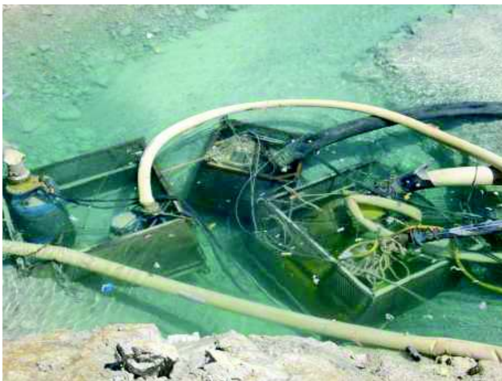
Slika 22: Prikaz začasnega črpališča s petimi potopnimi črpalkami
