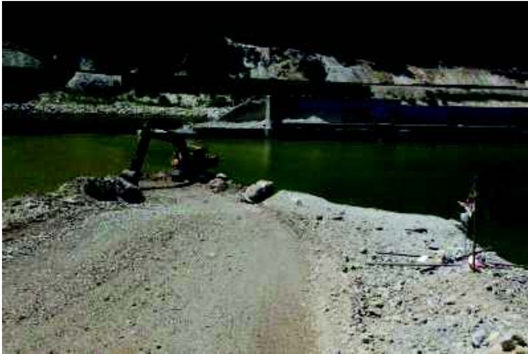
Slika 13: Zajezitev desne struge in preusmeritev reke Save na prelivna polja
