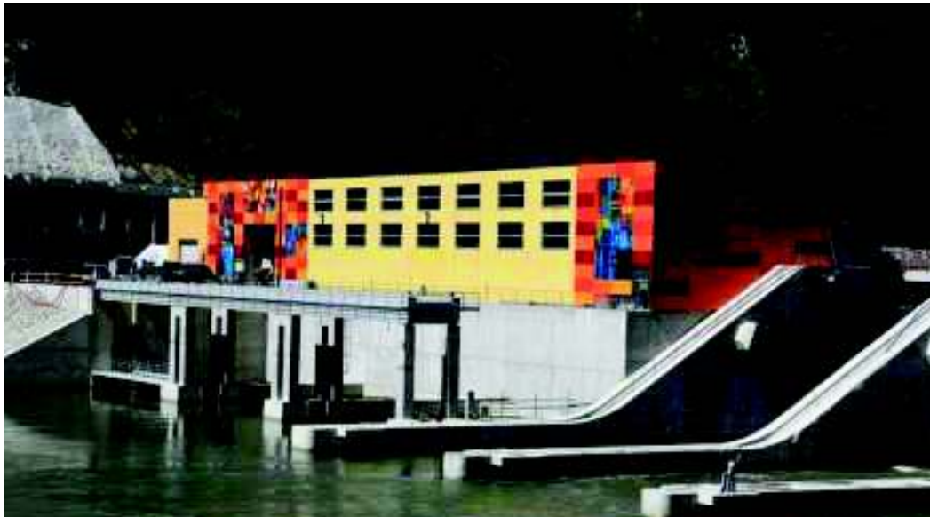
Slika 16: Strojnica - druga gradbena jama
