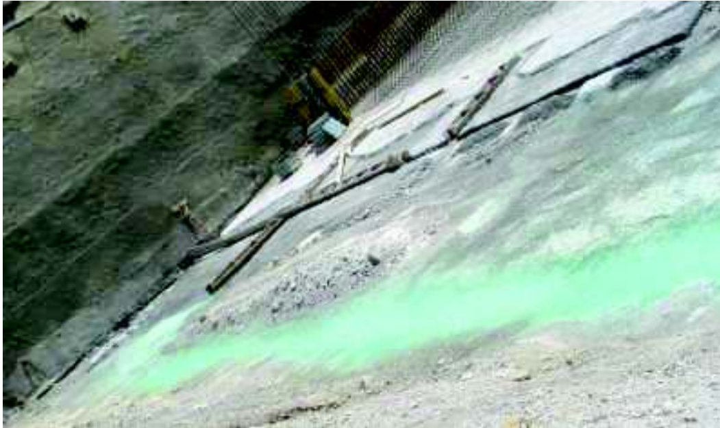
Slika 21: Prikaz dotoka vode z dna gradbene jame
