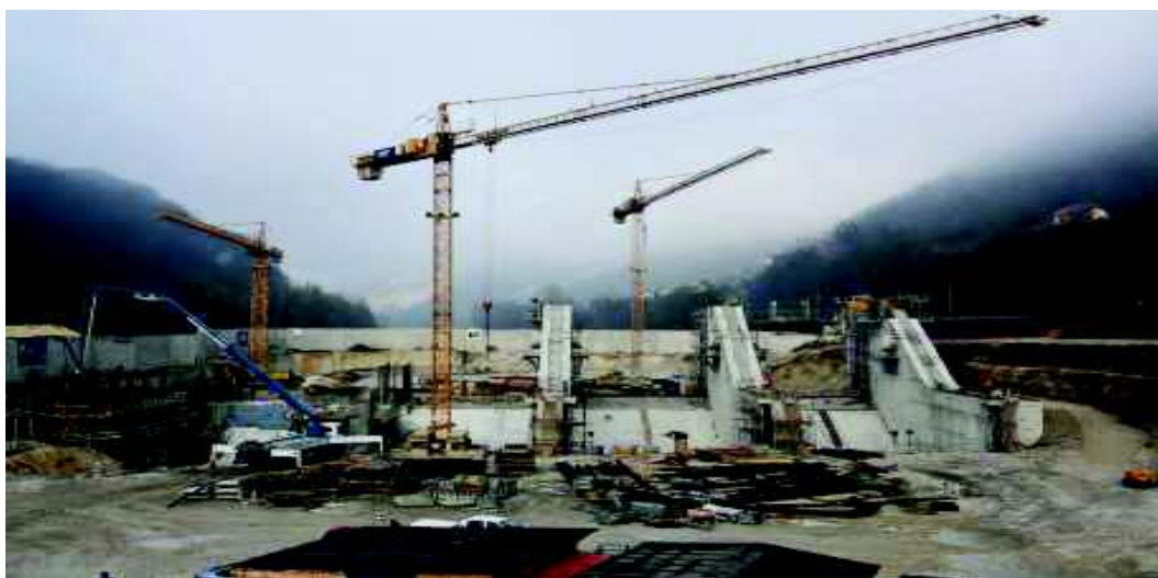
Slika 11: Gradnja stebrov prelivnih polj
