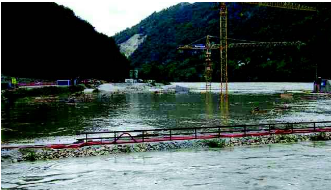
Slika 27: Poplavitev druge gradbene jame, na desnem bregu (dolvodno)
