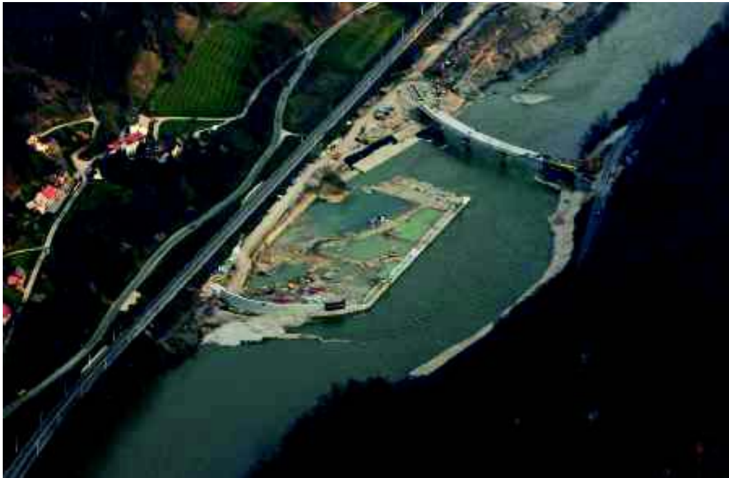
Slika 7: Prva gradbena jama– zračni posnetek
