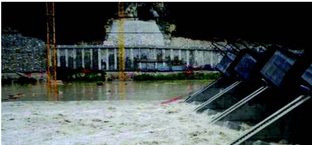
Slika 26: Poplavitev druge gradbene jame, na desnem bregu (gorvodno)
