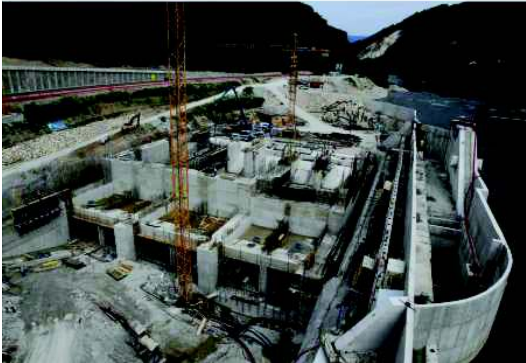
Slika 18: Gradnja osrednjega dela – trije agregati in peto prelivno polje
