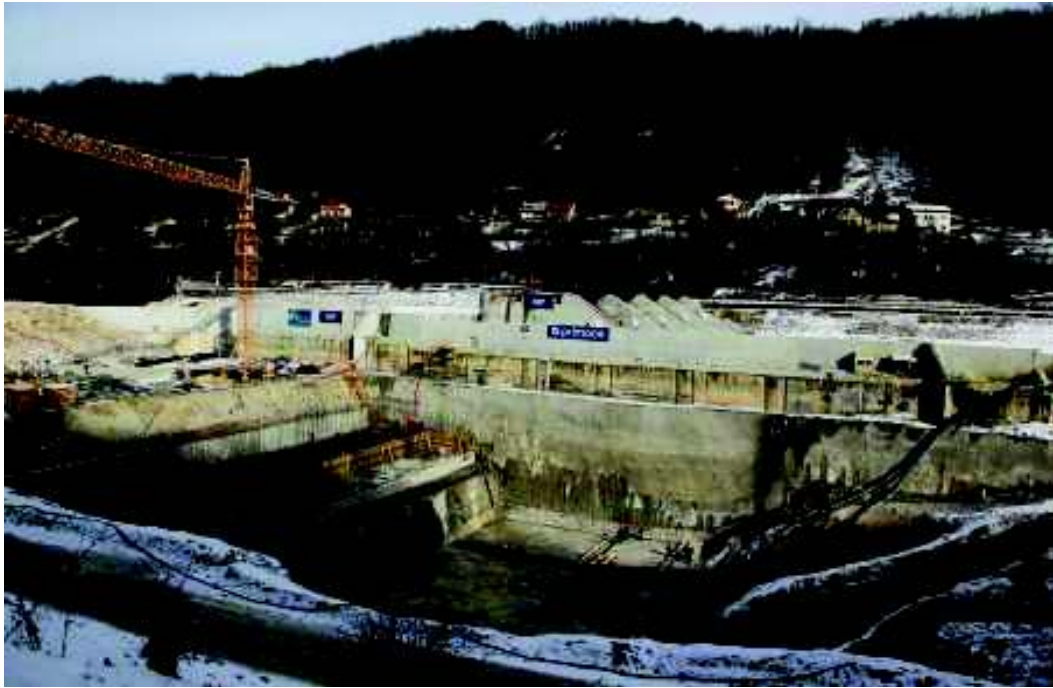
Slika 14: Druga gradbena jama, formirana na desnem bregu Save
