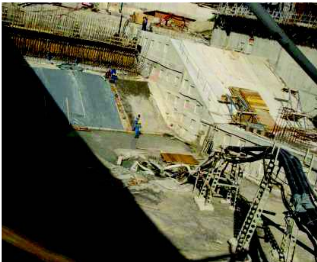
Slika 23: Prikaz glavnega črpališča z pomožno jekleno konstrukcijo
