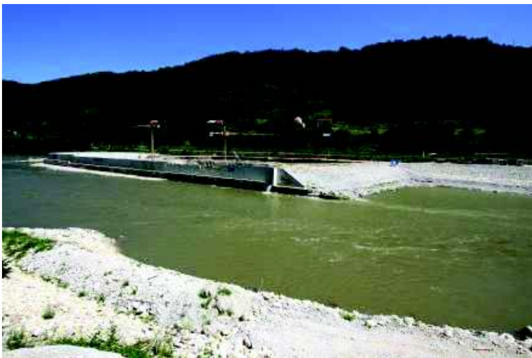
Slika 8: Ograditev gradbene jame: betonski obodni zid in dolvodni priključni nasip s tesnilno zaveso
