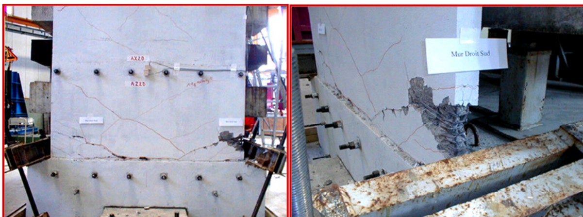
Slika 52: Tlačna porušitev betona v vogalu stene (Fischinger, M. 2010/2011)
