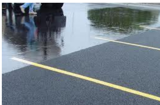
Slika 3: Razlika med drenažnim in običajnim asfaltom na parkirišču v ZDA (Google, 2012)
