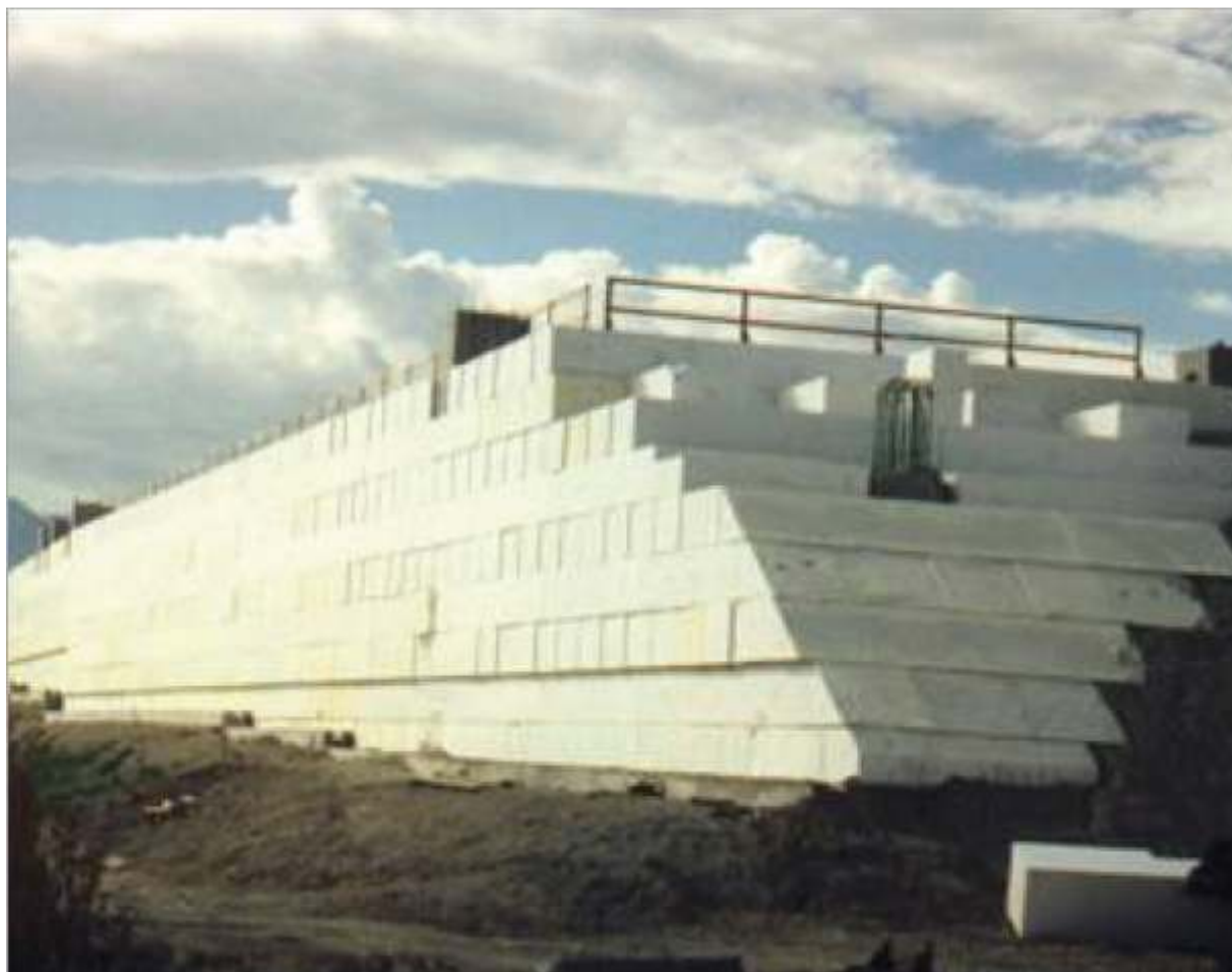
Slika 10: Izvedba nasipa iz ekspaniranega polistirena 1 ( http://www.achfoam.com/ , 28.7.2012)
