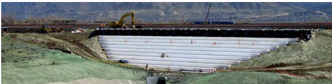
Slika 11: Izvedba nasipa iz ekspaniranega polistirena 2 ( http://www.achfoam.com/ , 28.7.2012)
