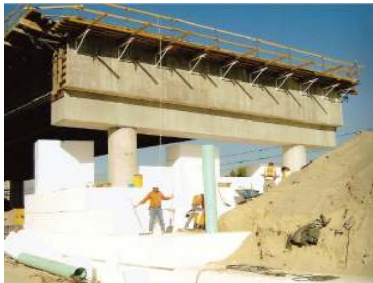
Slika 21: Gradnja priključnega nasipa k premostitvenemu objektu 1 ( http://www.achfoam.com/media/docs/Projects/Cottonwood%20Street.pdf , 2.11.2012)
