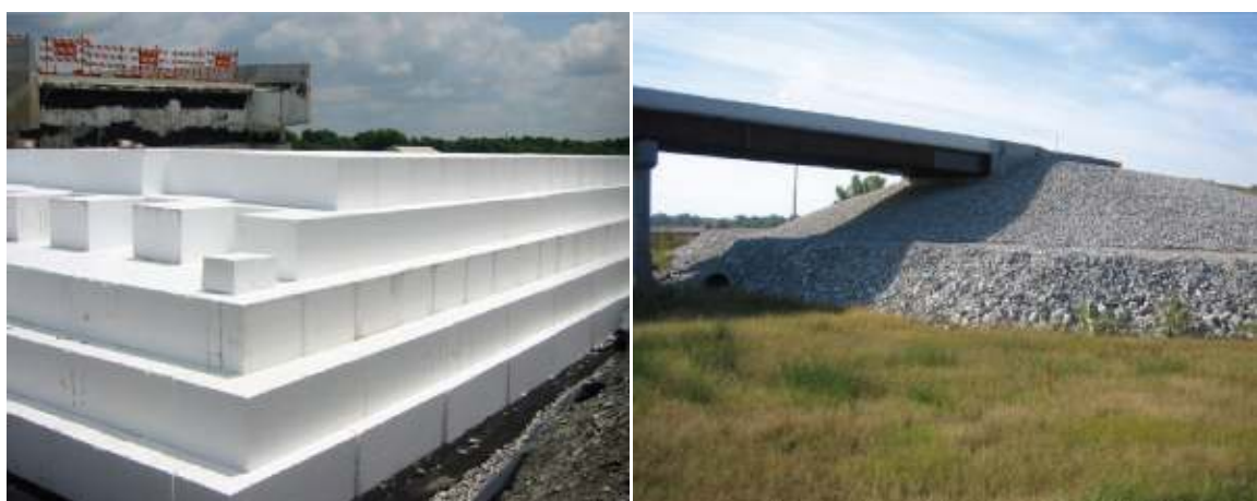
Slika 13: Izvedba priključnega nasipa k premostitvenem objektu ( http://www.achfoam.com/ , 28.7.2012)
