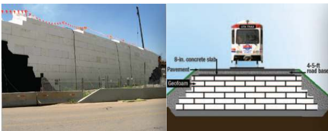
Slika 12: Izvedba nasipa iz ekspaniranega polistirena za potrebe železniškega prometa ( http://www.achfoam.com/ , 28.7.2012)
