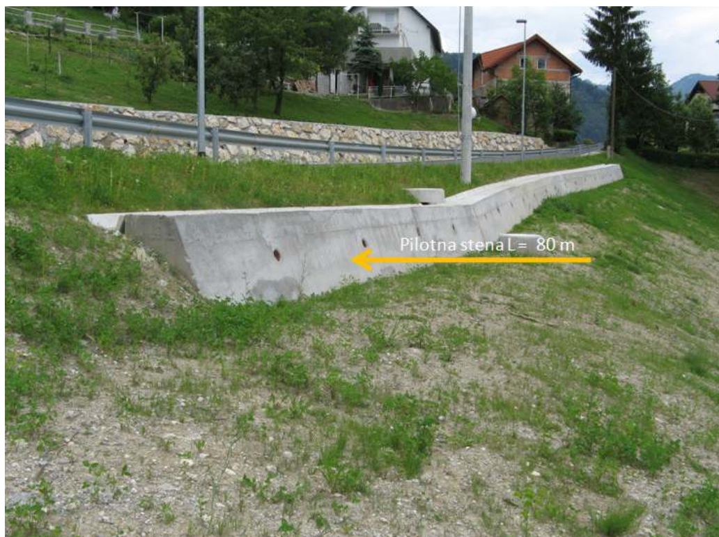
Slika 25: Pilotna stena (Marodi, 2011, str. 12).
