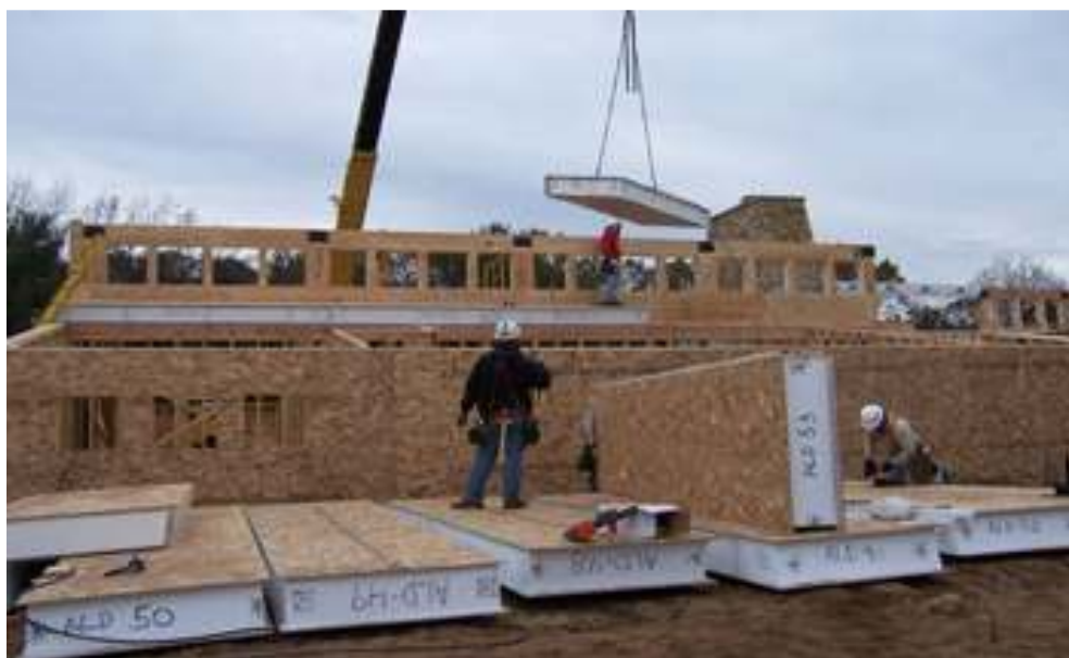
Slika 2: Primer uporabe stiropora v gradbeništvu
