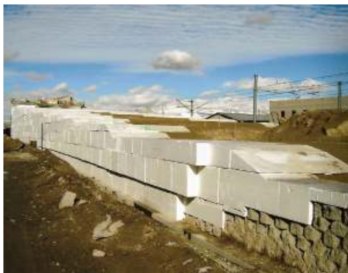
Slika 22: Gradnja priključnega nasipa k premostitvenemu objektu 2 ( http://www.achfoam.com/media/docs/Projects/Cottonwood%20Street.pdf , 2.11.2012)
