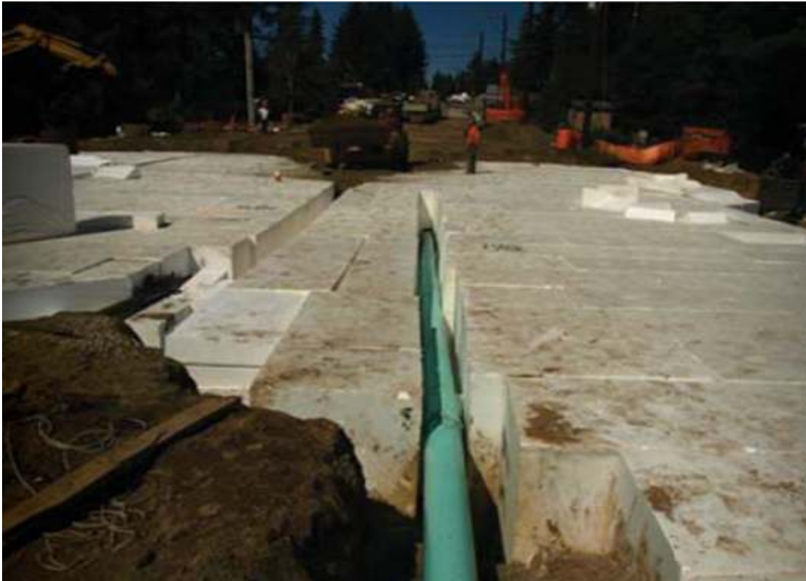
Slika 17: Postavitev drenažnih cevi za preprečitev dviga nasipa zaradi vzgona
