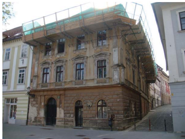
Slika 2: Obnova starega objekta v Ljubljani (vir: medmrežje 3)
