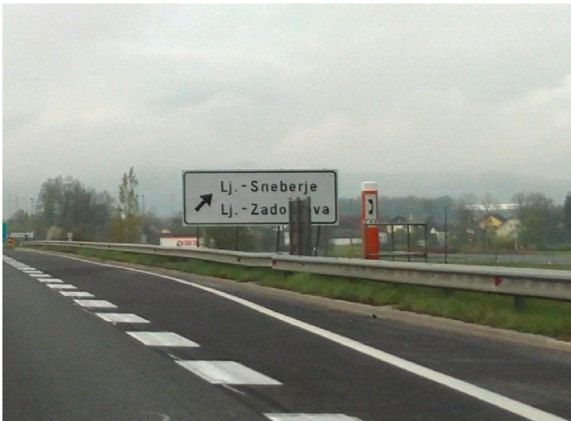
Slika 36: SOS telefon z nevarnim dostopom.
