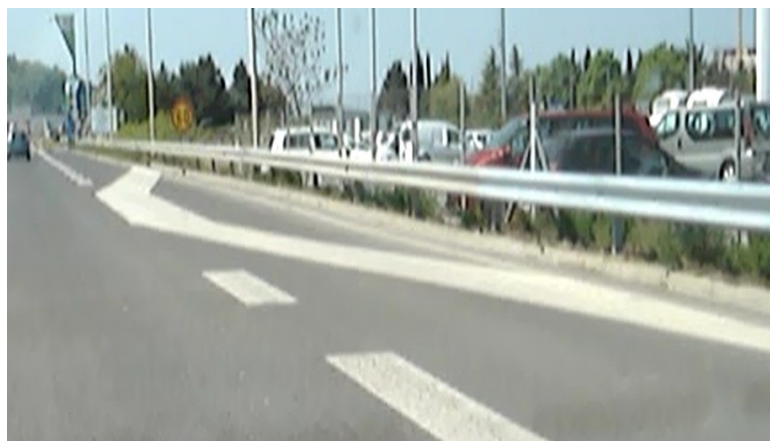
Slika 51: Zaporna ploskev med priključkom Koper - center in izvozom za bencinsko črpalko v smeri proti Izoli.
