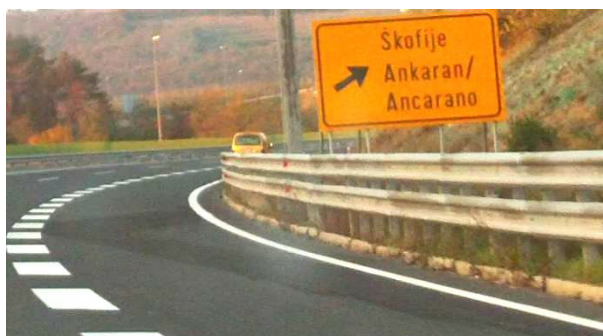
Slika 56: Odstranjena zaporna ploskev med priključkoma Dekani in Škofije.
