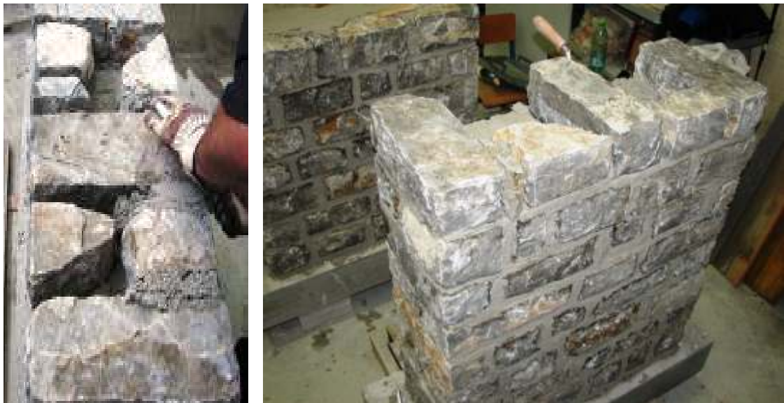
Slika 26: Zidanje sklada z vezniki
