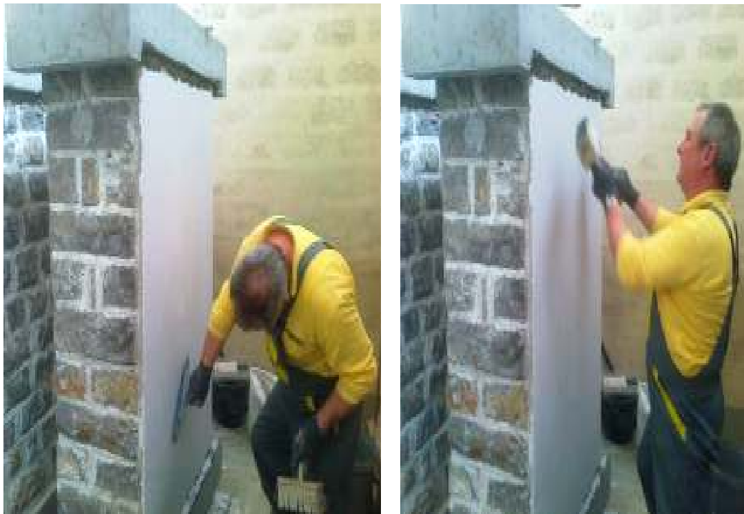
Slika 34: Ometanje s finim ometom
