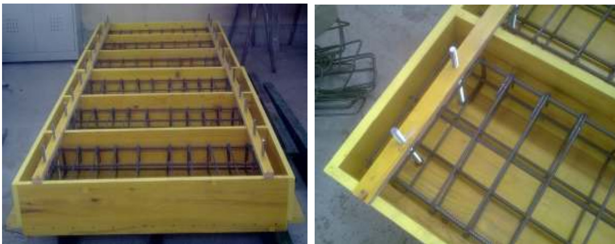
Slika 22: Opaž nosilca
