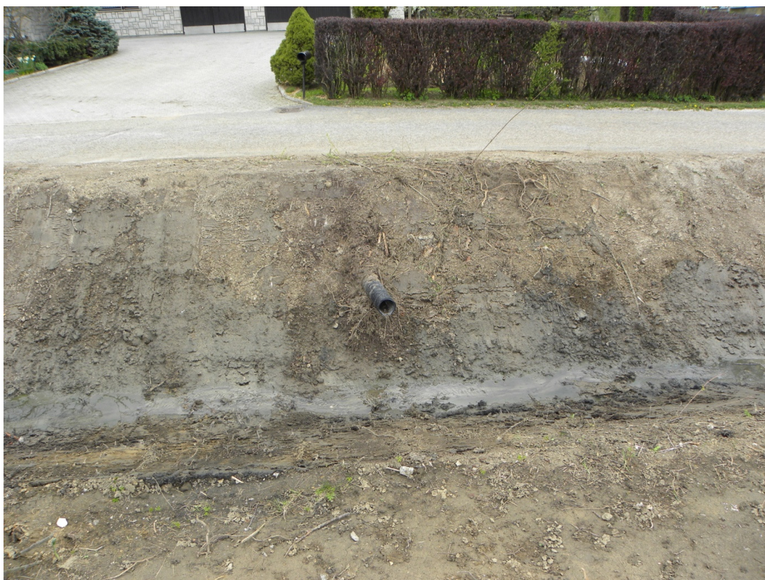
Slika 9: Iztok iz individualne greznice v skupni jarek v vasi Žlebič (vir: lastni)
