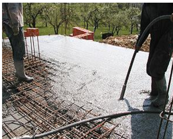
Slika 11: Vibriranje med vgrajevanjem betona (Pravi majstor, 2012).
