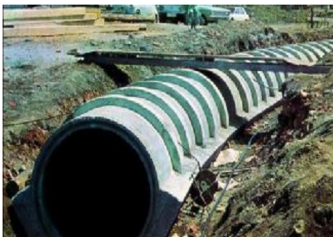
Slika 6: Betonska cev (Nivo, 2012).
