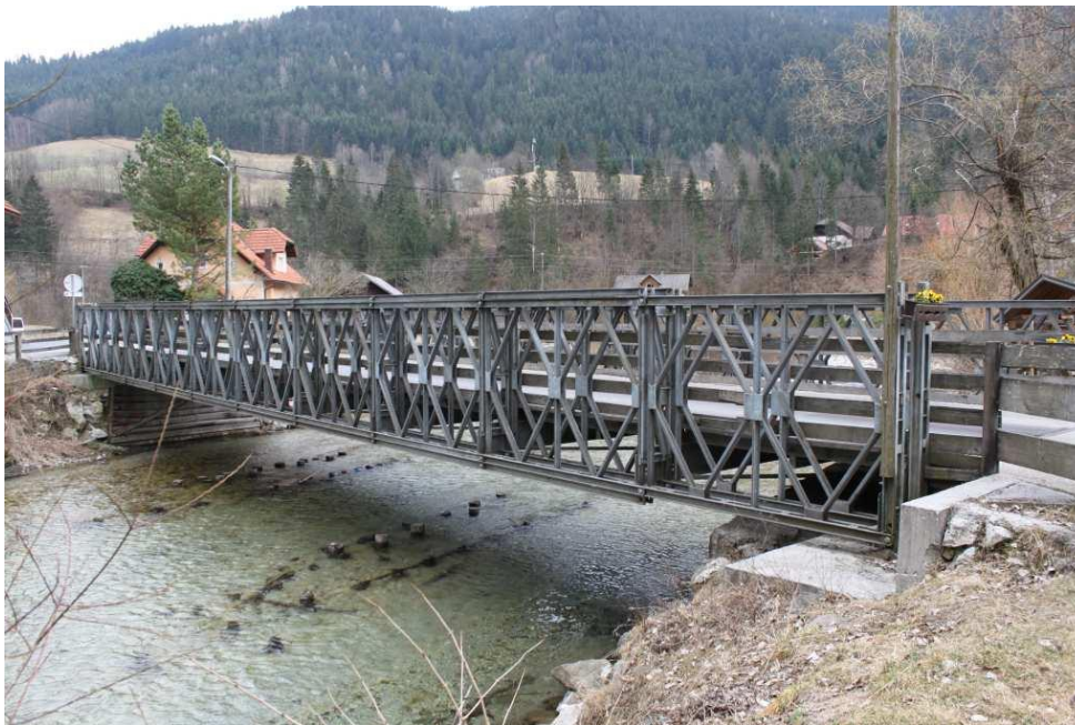
Slika 13: Začasni pontonski jeklen most čez Savinjo
