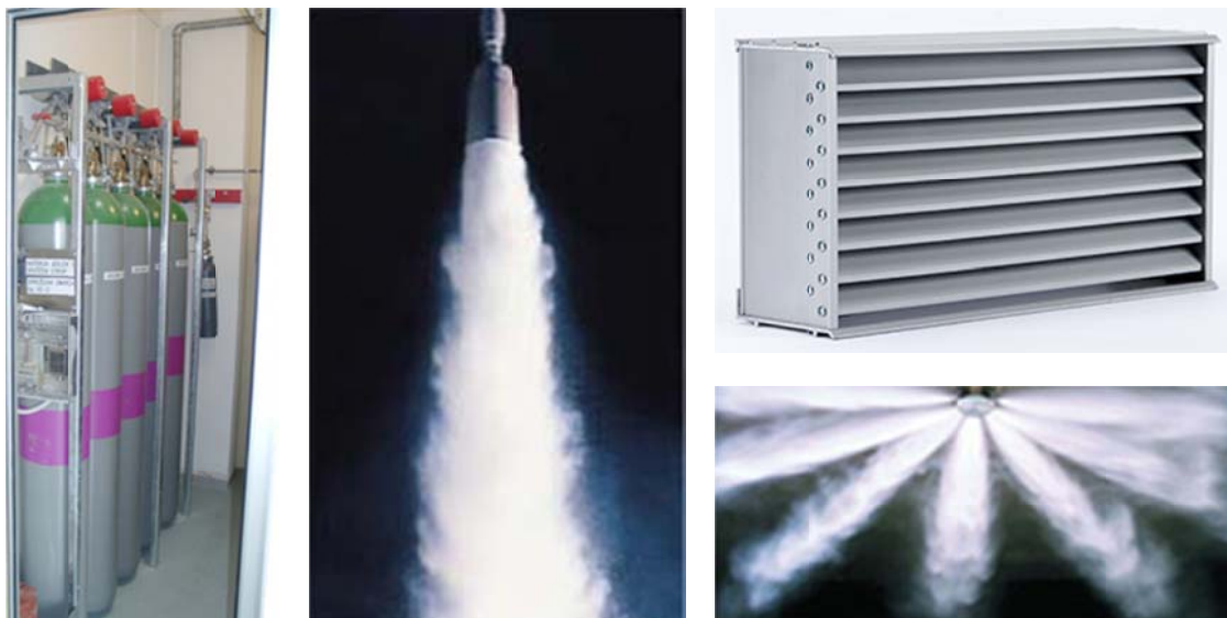
Slika 6-32: Prikaz zalogovnika CO 2 in vpihovalnih šob (vir: www.imp.si/immppps/plin.html )
