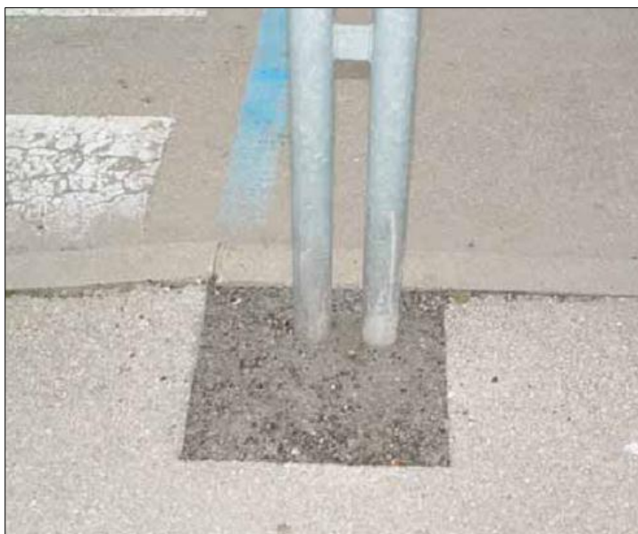
Slika 42: Primer vgrajene hladne bituminizirane zmesi okoli vertikalne signalizacije (TAHTING, 2012) [20]
