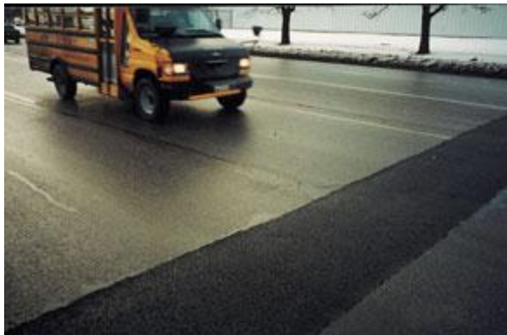
Slika 43: Prekop čez cesto saniran s hladno bituminizirano zmesjo (Cantat Associates Inc., 2012) [23]
