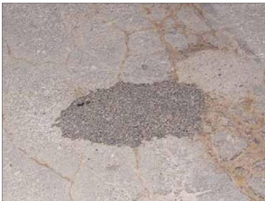
Slika 37: Primer vgrajene hladne bituminizirane zmesi po postopku vrzi in pojdi (TAHTING, 2012) [20]
