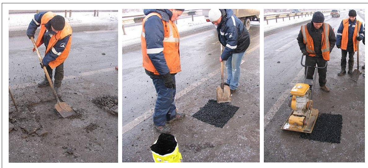
Slika 40: Sanacija poškodbe na cesti – Chelyabinsk, Russia (Cantat Associates Inc., 2012) [22]
