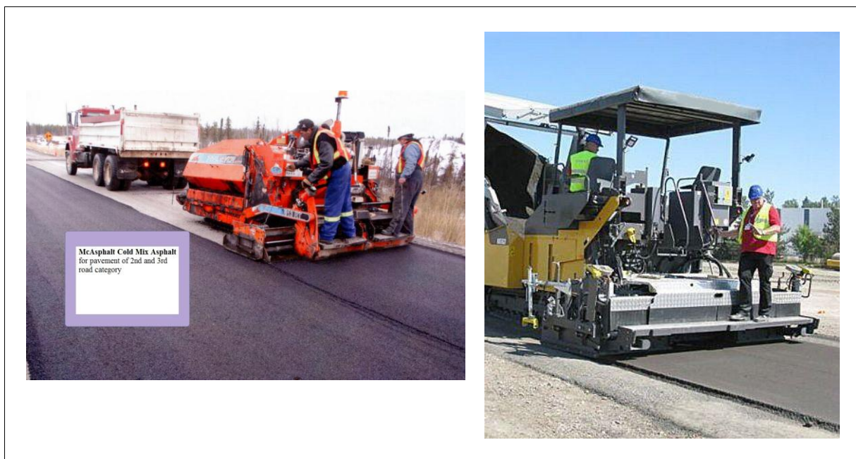
Slika 46: Asfaltiranje (Cantat Associates Inc., 2012) [23]
