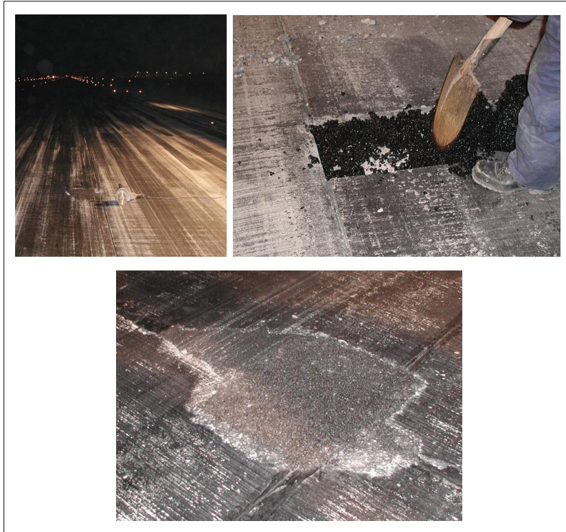
Slika 48: Sanacija poškodbe na letališki stezi (Cantat Associates Inc., 2012) [23]
