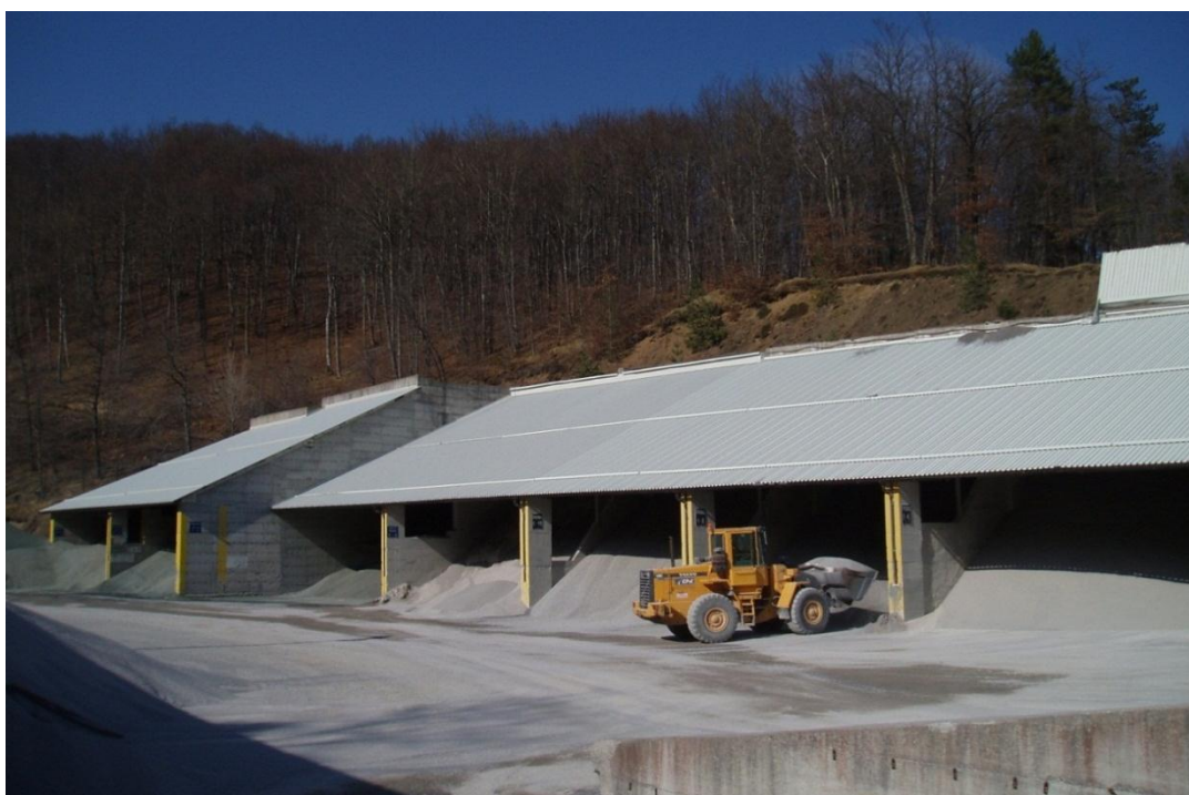
Slika 14: Deponija za zmesi kamnitih zrn ločene po frakcijah
