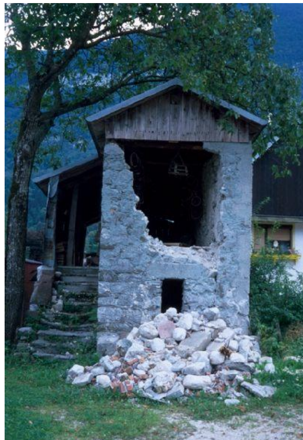
Slika 8: Slika a) prikazuje razpoke, ki jih je povzročil potres 2004, slika b) priča o podoru ob reki Soči, kot posledici potresa 2004, slika c) pa kaže stavbo stare gradnje, ki jo je porušil potres 2004 (Serbianmeteo, 2012)
